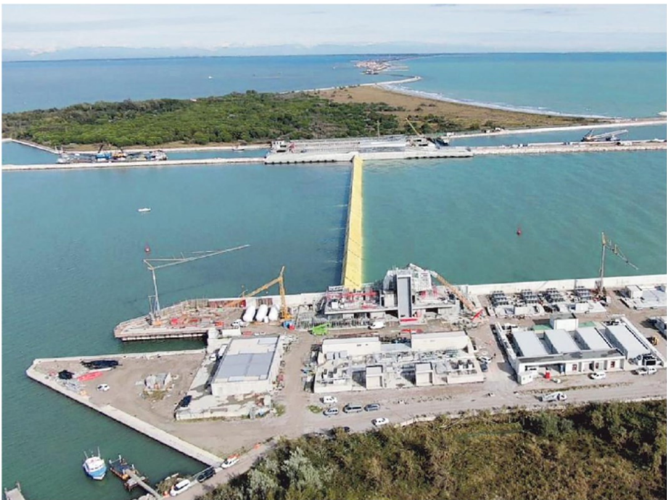
La conca di navigazione, costruita sul lato sud della bocca di porto di Malamocco: inutilizzata a causa della mareggiata di cinque anni fa
