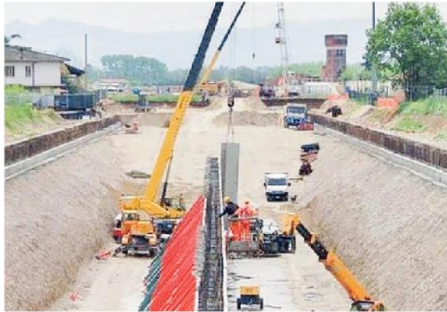
Un cantiere della Pedemontana Veneta
