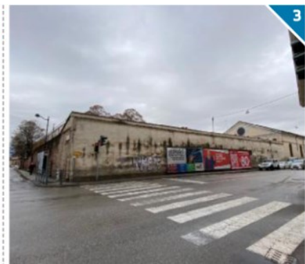
3 Il muro che verrebbe demolito tra via Bonollo e contra' Porta Nova
