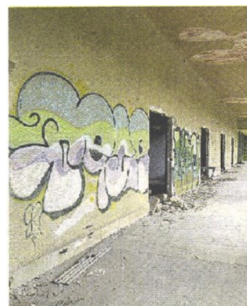
DEGRADO ALL'EX COLONIA Da anni è abbandonata
