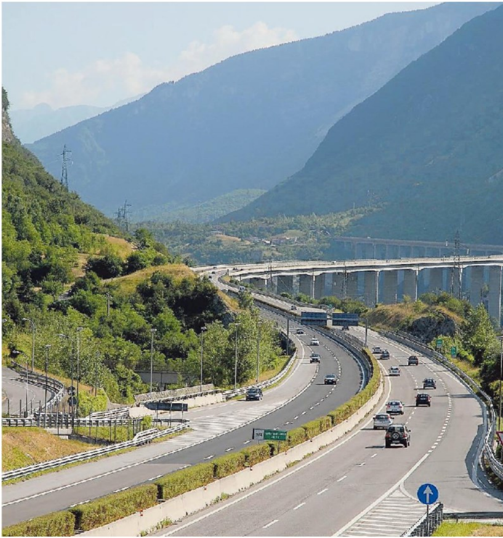
Una veduta di un tratto della A27 che sale da Venezia e si ferma per ora a Pian di Vedoia
