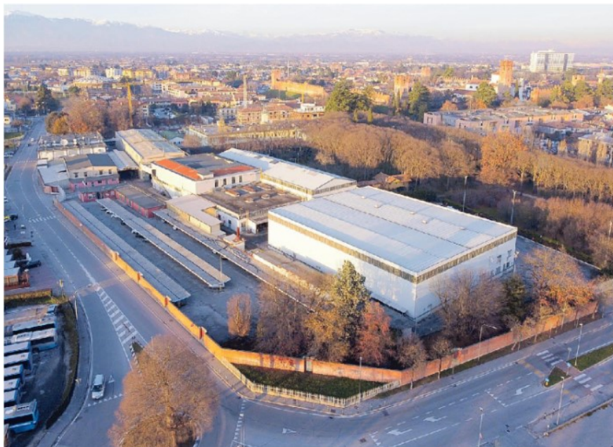
LA STORICA AZIENDA DI ANTENNE CAMBIA PELLE
