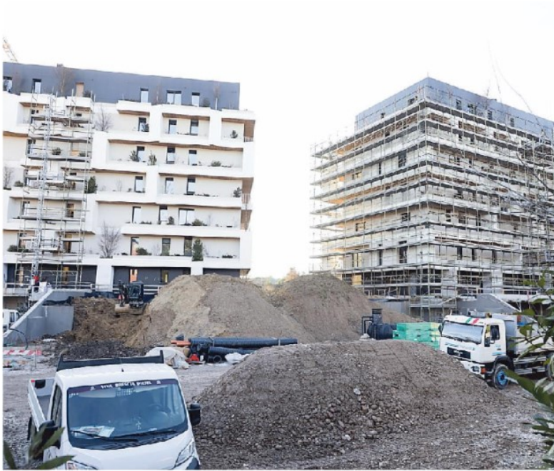
BOSCO VERTICALE in Restera, iniziativa delle Cazzaro Costruzioni, è ormai alle ultimissime battute
