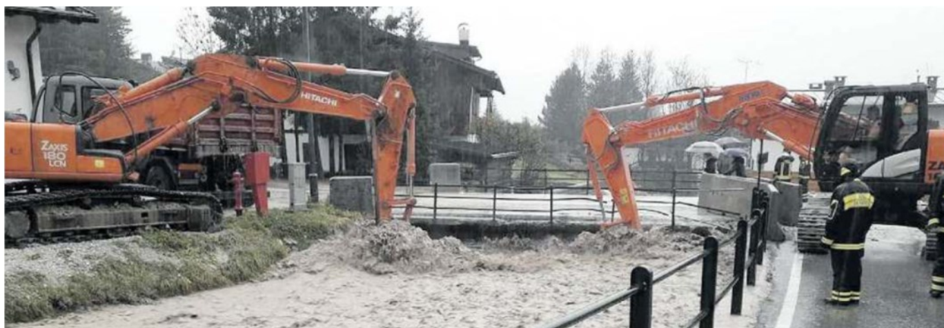
I DANNI DI FINE OTTOBRE La ricostruzione post maltempo aprirà una porta importante per il settore delle costruzioni, da anni in forti difficoltà. Ingenti le somme in ballo contro i dissesti
