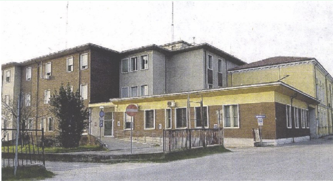
EX OSPEDALE Via libera dell'Ulss5 polesana al progetto per il rilancio della struttura
