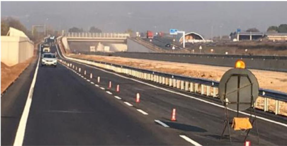
Uno scorcio dello svincolo di via Molinetto, a Montecchio Maggiore, riaperto dopo 5 mesi di lavori
