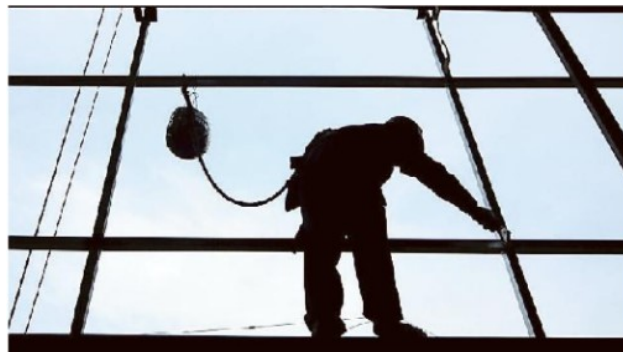
Un operaio edile al lavoro in un cantiere
