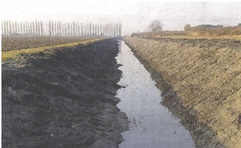
CONSORZIO DI BONIFICA L'ente ha già iniziato a riparare i canali danneggiati dal maltempo.
