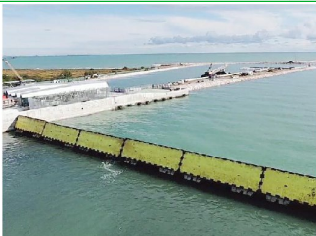
Le paratoie del Mose innalzate per l'acqua alta
