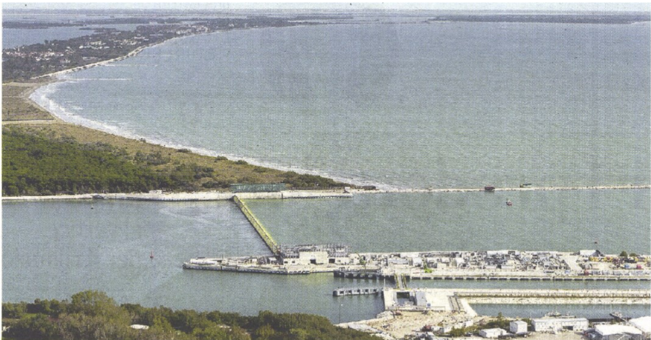
SISTEMA DI DIFESA Una delle dighe mobili del Mose sollevate per difendere Venezia e la laguna dalle acque alte
