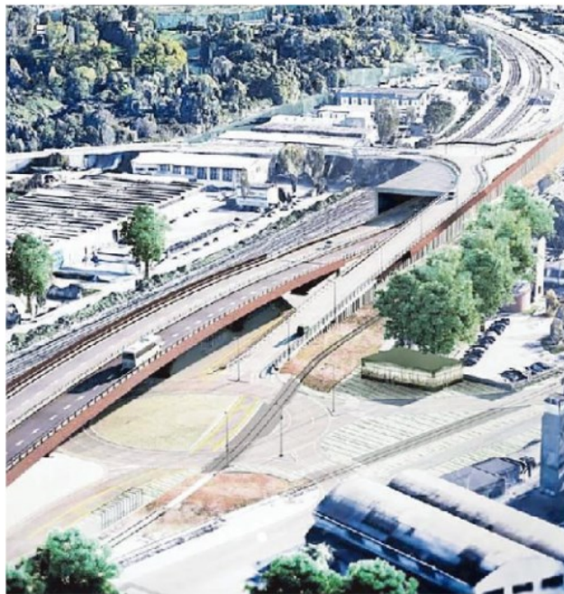
Nuovi cantieri stradali a Mestre, i lavori dureranno fino al 2023
