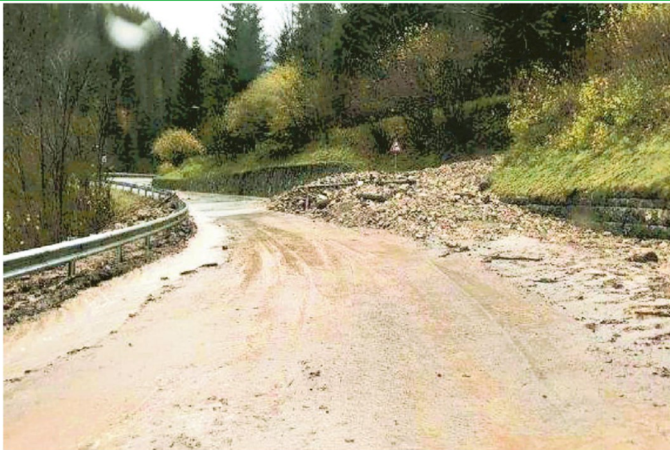
La strada Provinciale 251 in Val di Zoldo dopo l'alluvione
