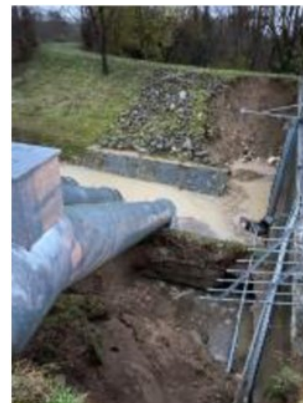
L'intervento sulla Caveggiara
