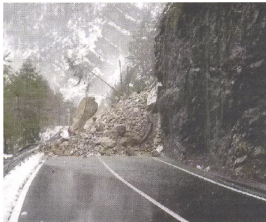
VIABILITÀ DISASTRATA La frana scesa il 5 dicembre, poi rimossa
