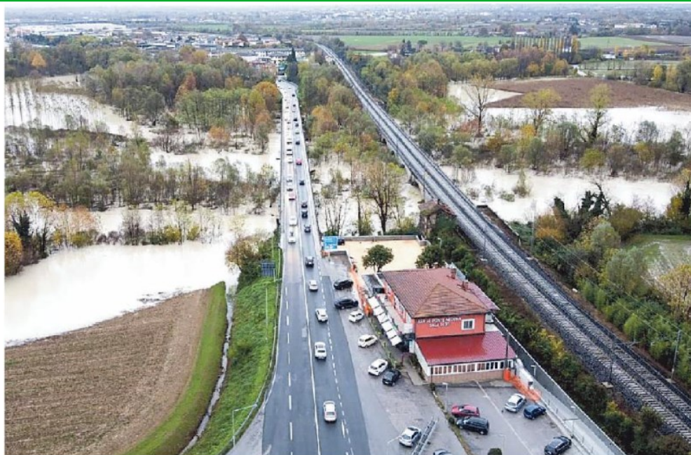
Una veduta di Ponte Meduna. Quest'anno si vivrà la fase centrale della progettazione dell'opera FOTO MISSINATO
