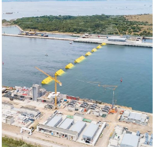
Le barriere del Mose nel corso di un sollevamento
