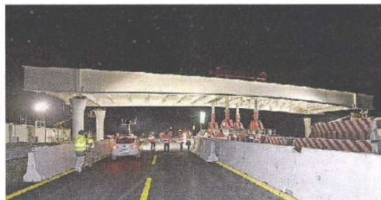
LAVORI IN CORSO La posa del nuovo cavalcavia dell'A4 ad Alvisopoli
