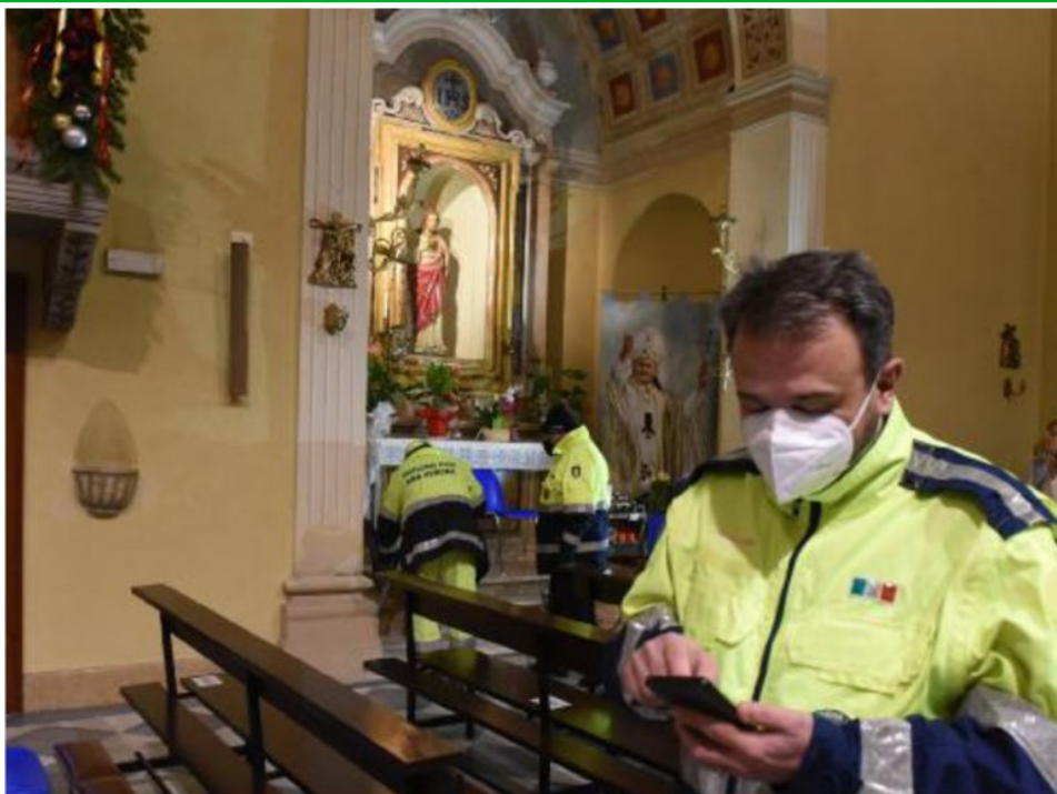
Il sopralluogo alla chiesa di Salizzole, nel Veronese, dopo il sisma di magnitudo 4,4 del 29 dicembre
