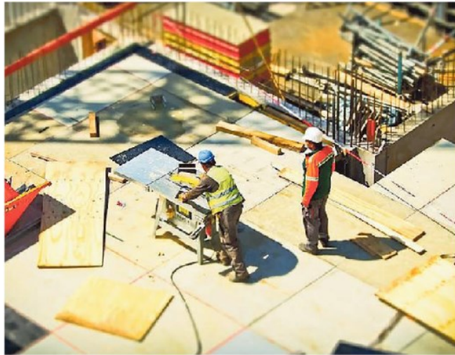
Operai al lavoro in un cantiere edile
