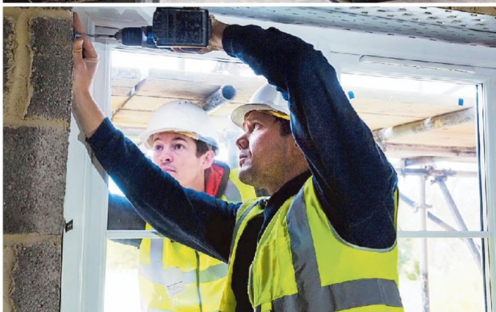
In alto l'entrata di Wellio, l'ufficio plug&play. Sopra rinnovo degli infissi, misura che gode del Superbonus
