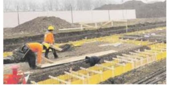
OPERAI al lavoro nel cantiere della nuova scuola elementare di Lovadina: un investimento da quasi due milioni di euro
