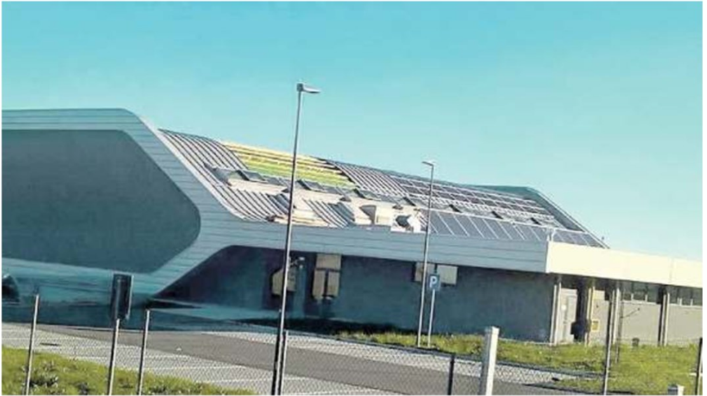
VILLADOSE II Palazzetto dello Sport di via Serafino Zennaro danneggiato dal vento e attualmente chiuso per precauzione
