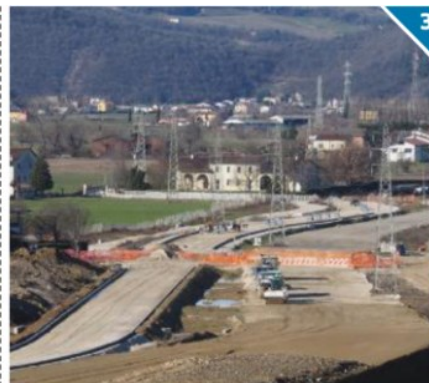
3 La strada che verrà aperta tra due mesi tra il Biron e viale del Sole
