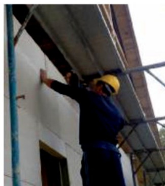
Una ristrutturazione edilizia
