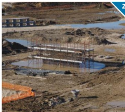
2 Le strutture che serviranno per realizzare i piloni del viadotto
