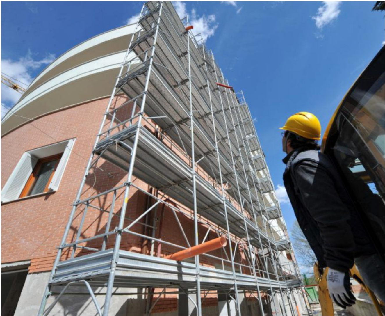
Un cantiere edilizio: quelli legati al Superbonus 110 per cento cominceranno ad aprirsi a maggio
