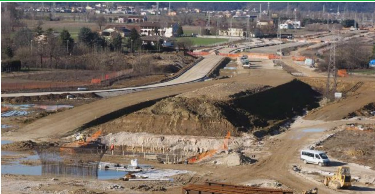
Un'immagine dei lavori della bretella dell'Albera lungo viale del Sole: si vedono gli elementi per il viadotto. SERVIZIO COLORFOTO
