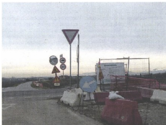
IL CANTIERE Sono partiti i lavori in via Albano Villanova per realizzare la passerella ciclopedonale sul Monticano
