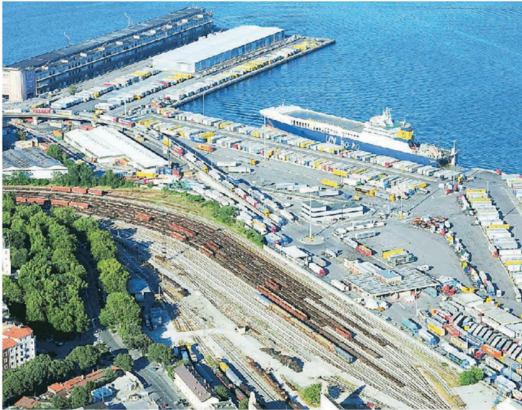
Una veduta aerea di una porzione del porto di Trieste, con un tratto dell'infrastruttura ferroviaria
