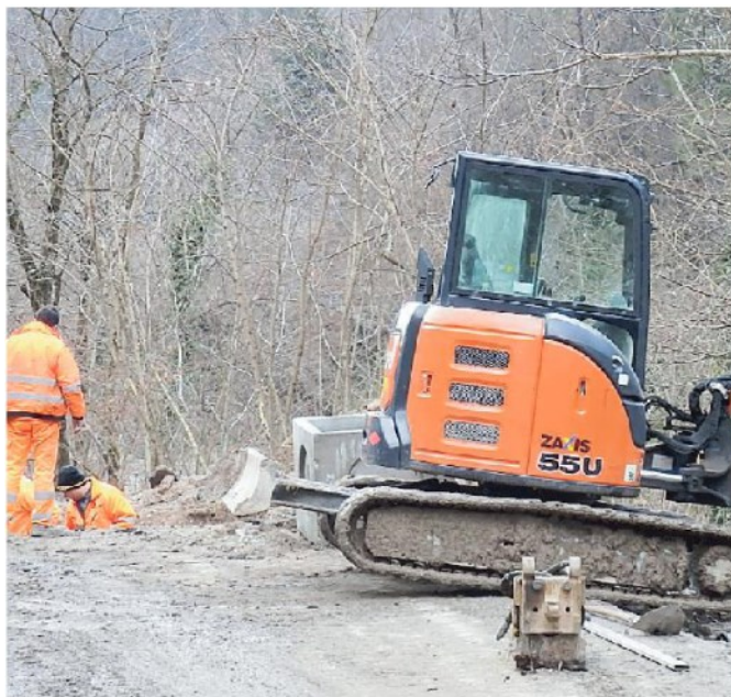
Operai della ditta Fontana al lavoro in Val Canzoi
