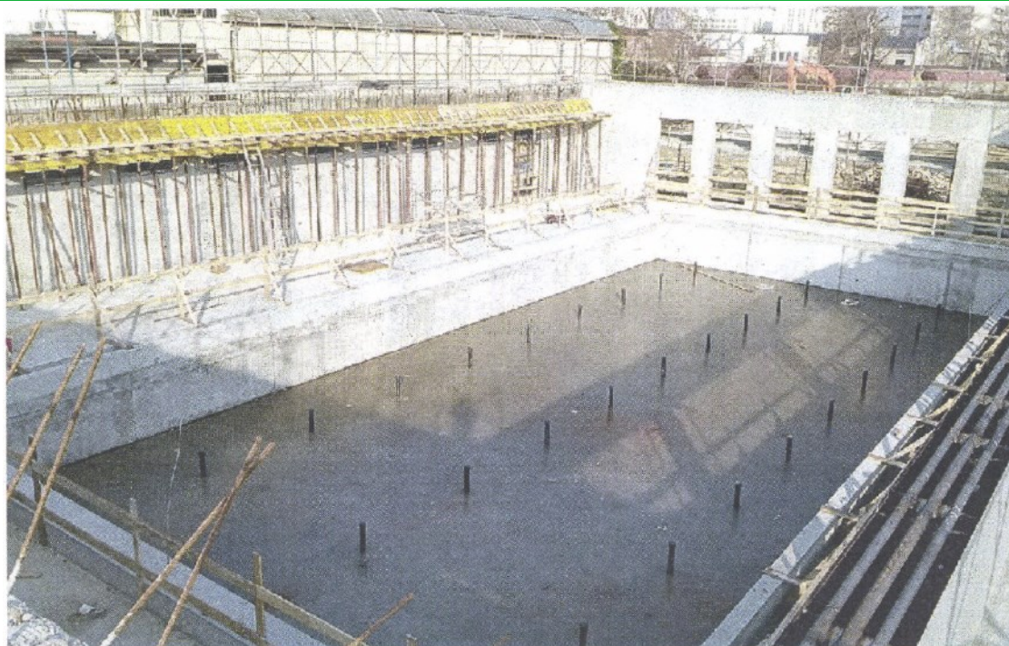
IL CANTIERE La vasca da 25 metri della nuova piscina e, nel tondo, il sopralluogo in via delle Macchine del vicesindaco e assessore allo Sport, Andrea Tomaello
