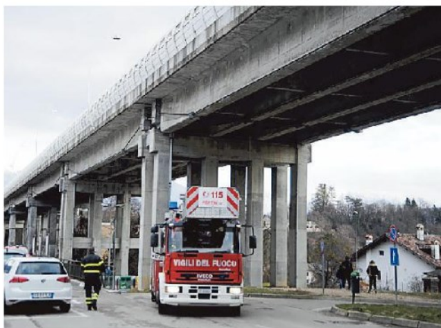
L'intervento dei vigili del fuoco ieri sotto al ponte degli alpini
