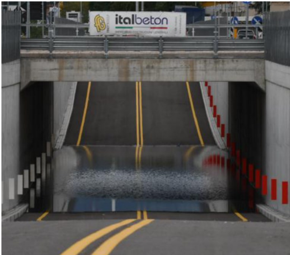
Il sottopasso è risultato inagibile già a settembre a causa degli allagamenti provocati dal maltempo
