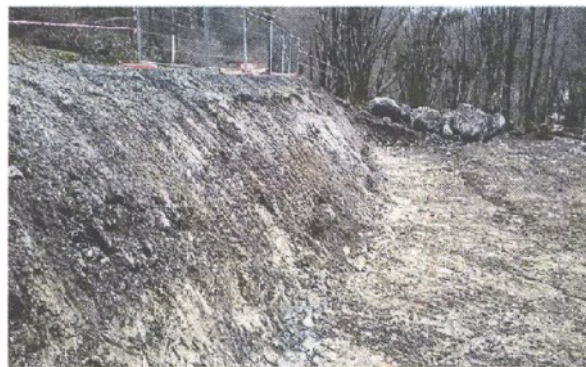
LAVORI IN CORSO Uno dei cantieri in Valle di Canzoi
