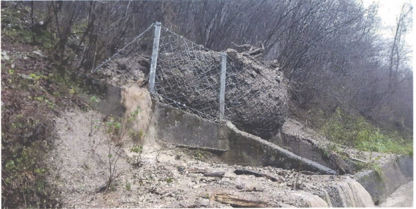
LA FRANA caduta lungo la strada comunale che porta alla frazione di Canal agli inizi del mese di dicembre 2020
