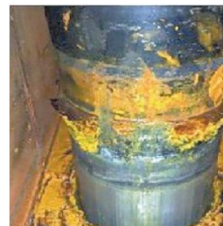
La corrosione nelle cerniere
