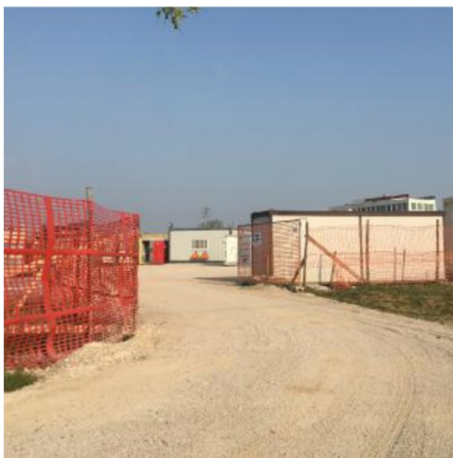
L'entrata (libera) al cantiere della tangenziale in zona viale del Sole
