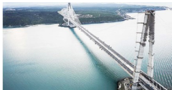
Astaldi. Il terzo ponte sul Bosforo a Istanbul
