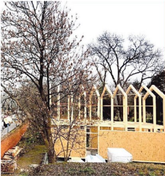
Una fase del cantiere per la costruzione delle dependance
