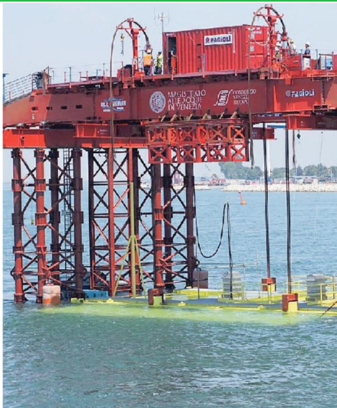
Installazione delle prime paratoie del Mose nel 2013
