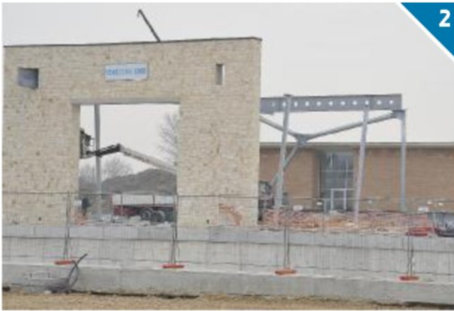
In fase avanzata di realizzazione i caselli Spv a Montecchio. TROGU
