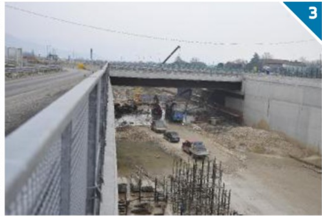
I lavori al sottopasso della rotonda in direzione di Montebello. TROGU
