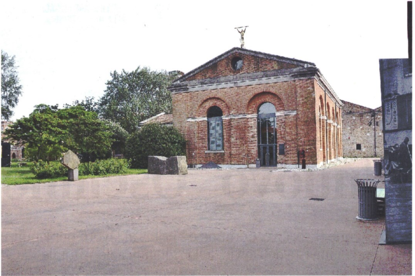
ARSENALE Il complesso che ospita la sede di Thetis, società controllata dal Consorzio Venezia Nuova
