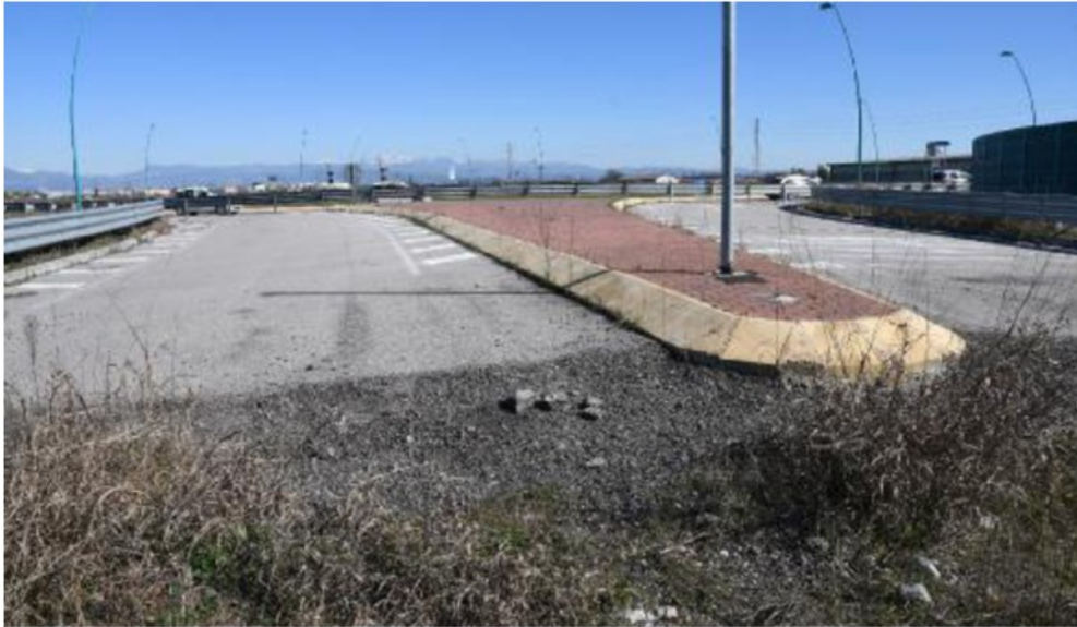
Il tratto incompiuto della Grezzanella per cui si sono già spesi diversi milioni
