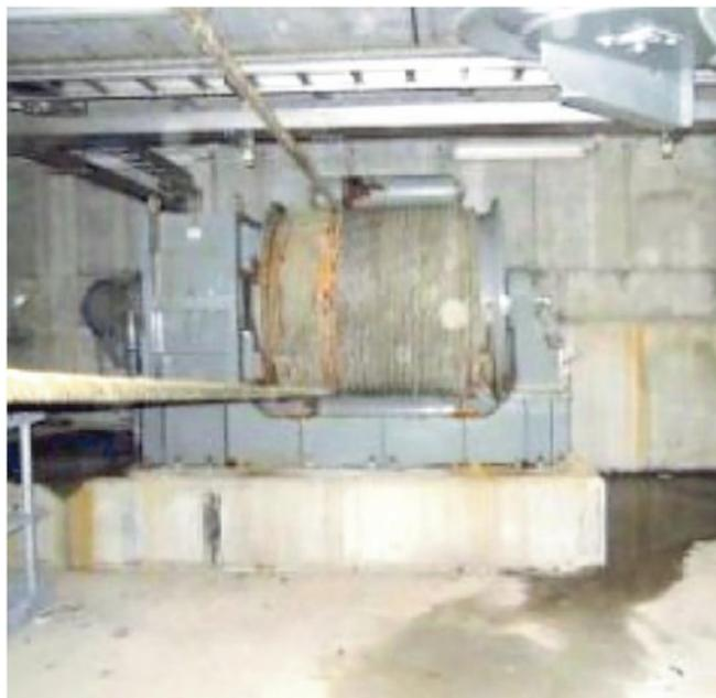
Bobine e meccanismi degradati nelle gallerie di Malamocco
