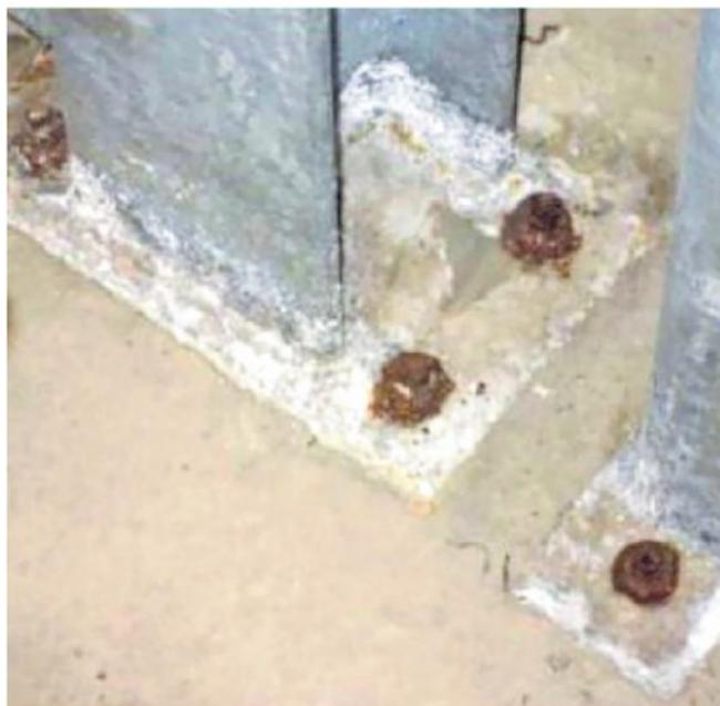
I bulloni arrugginiti tengono la struttura sott'acqua
