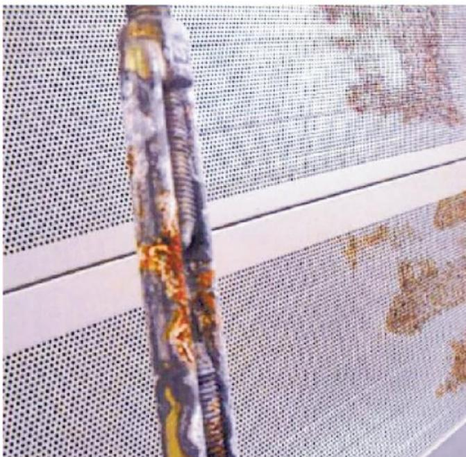
Infiltrazione e corrosione nelle griglie di aerazione
