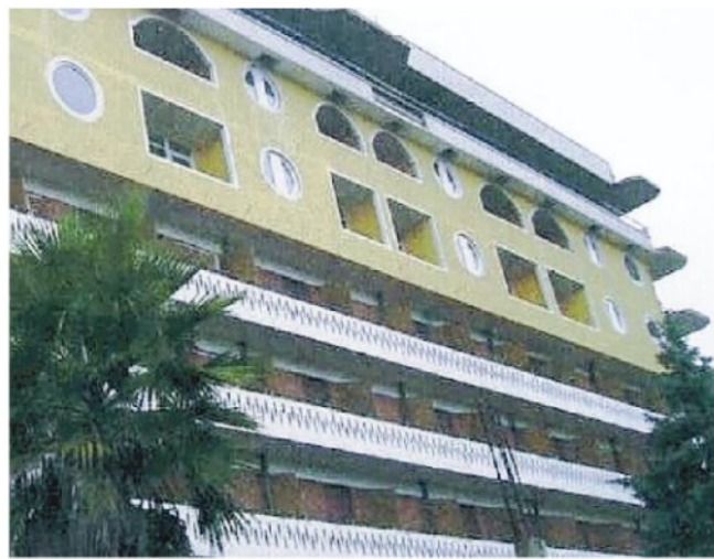
L'hotel Rio d'Oro a Montegrotto prossimo all'abbattimento
