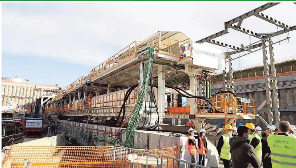
Ottobre 2020: Il taglio del nastro del cantiere dell'Alta velocità ferroviaria sulla tratta Brescia Est-Verona
