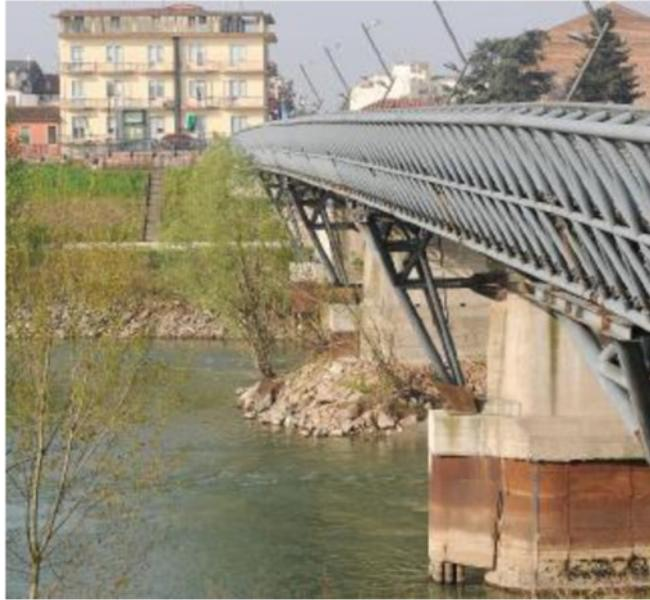
Ponte Principe Umberto: una delle pile mostra segni di cedimento
