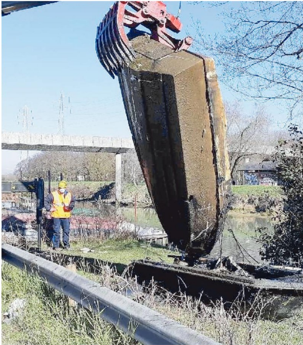
I lavori preliminari di pulizia dell'Osellino: hanno fatto emergere dai fondali una montagna di rifiuti
