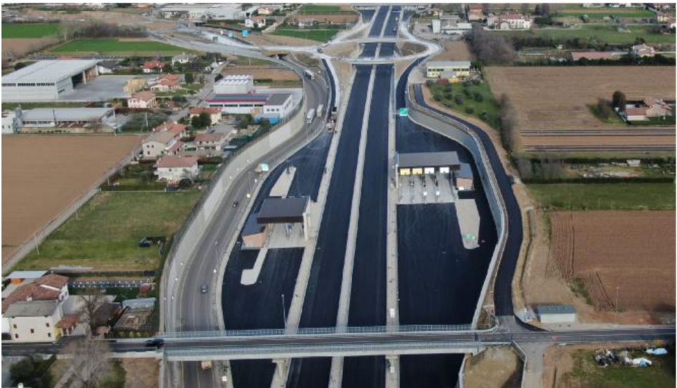
Il casello di Bassano Est situato fra San Zeno e Rosà. Sulla sinistra la complanare, variante alla ss47, che si dirige a nord. FOTO CECCON
