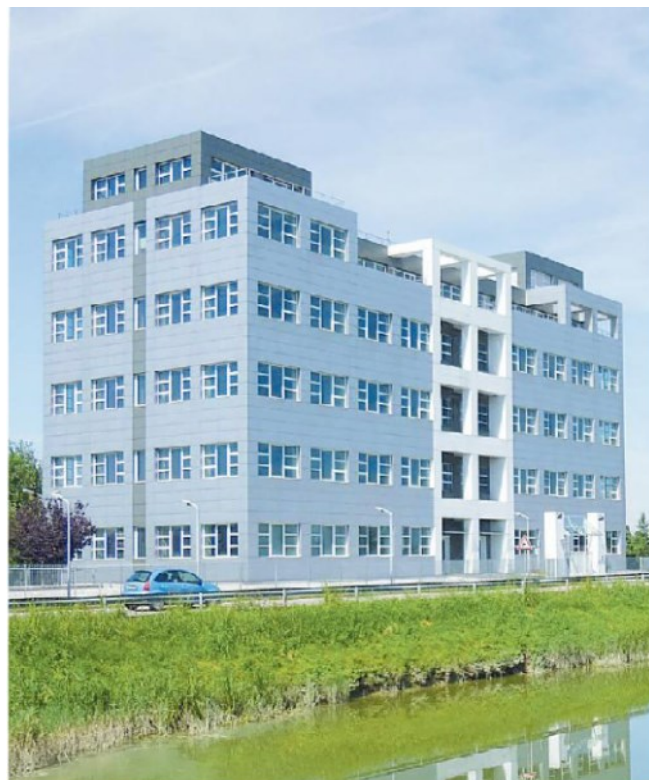
Il complesso di via Silos, che ospiterà gli uffici Atvo
