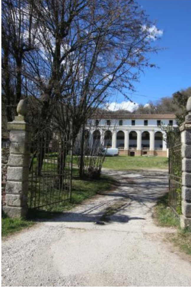
Villa Ghellini a San Tomio, vicina al cantiere Spv. FOTODONOVAN CISCATO
