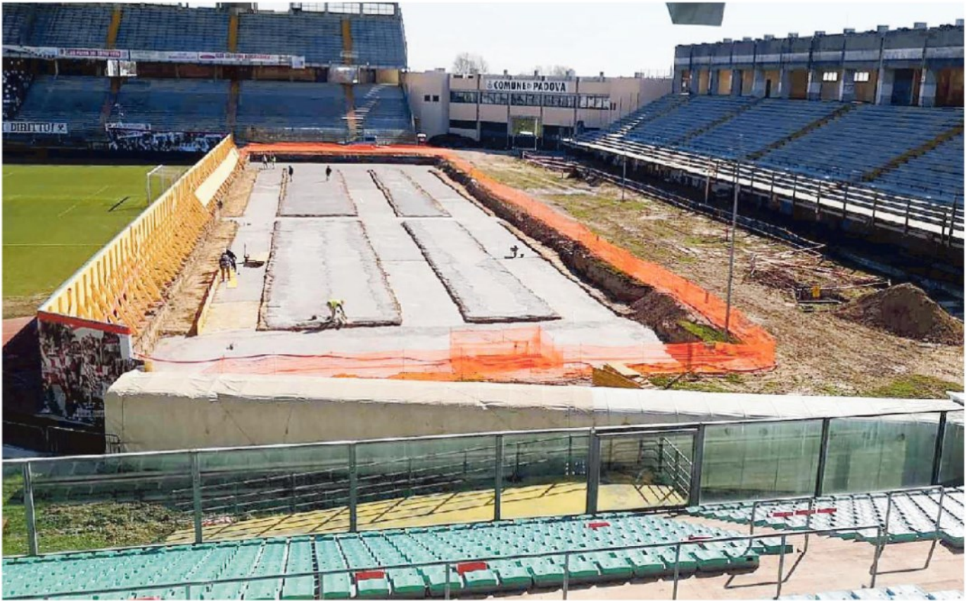
Sopra e sotto le immagini delle fondamenta della nuova curva sud dell' Euganeo che sarà dietro la porta a ridosso del campo
