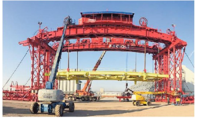
La cavalletta utilizzata per installare le paratoie. È in cantiere
