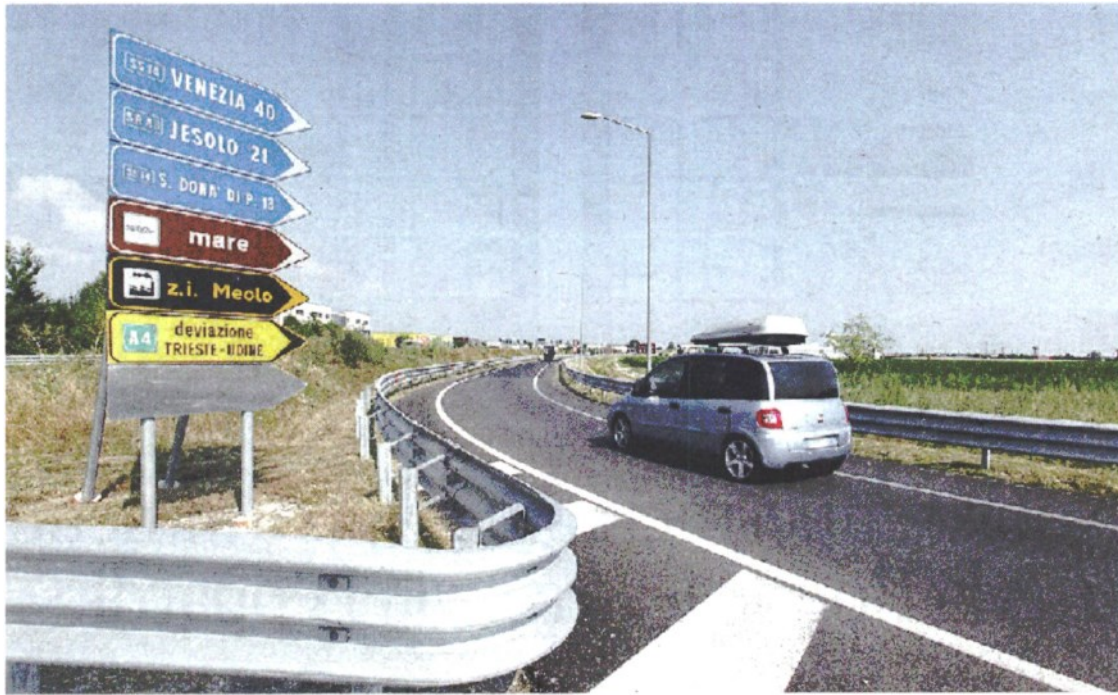
AUTOSTRADA DEL MARE La rotonda all'uscita del casello di Meolo: da qui dovrebbe partire la nuova arteria che dovrebbe permettere ai turisti di raggiungere le spiagge senza troppe code
