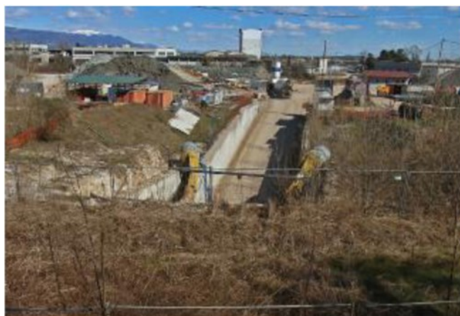
Il cantiere della Pedemontana a San Tomio. FOTO DONOVAN CISCATO
