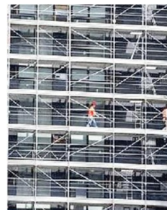
Un cantiere edile
