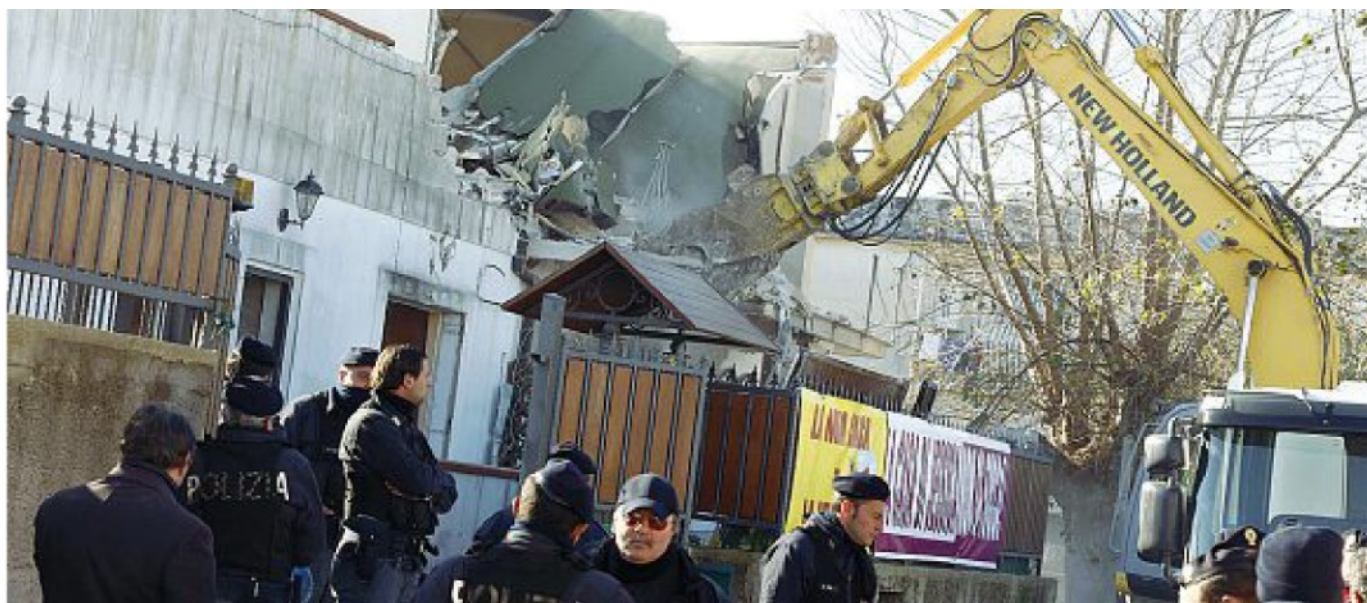
Tensione La demolizione di un immobile abusivo qualche anno fa in provincia di Napoli
