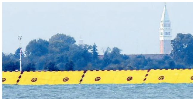
Le paratoie sollevate: domani se ne alzeranno quattro a Chioggia
