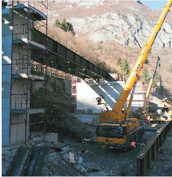
Cantiere Anas nel Bellunese: in corso opere per 2,9 miliardi
