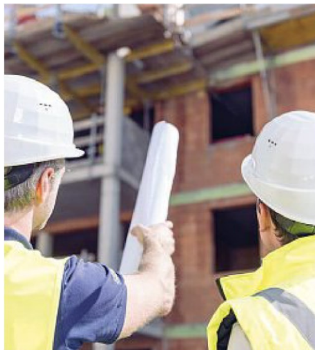
Gli interventi Mirano alla ristrutturazione e al miglioramento energetico
