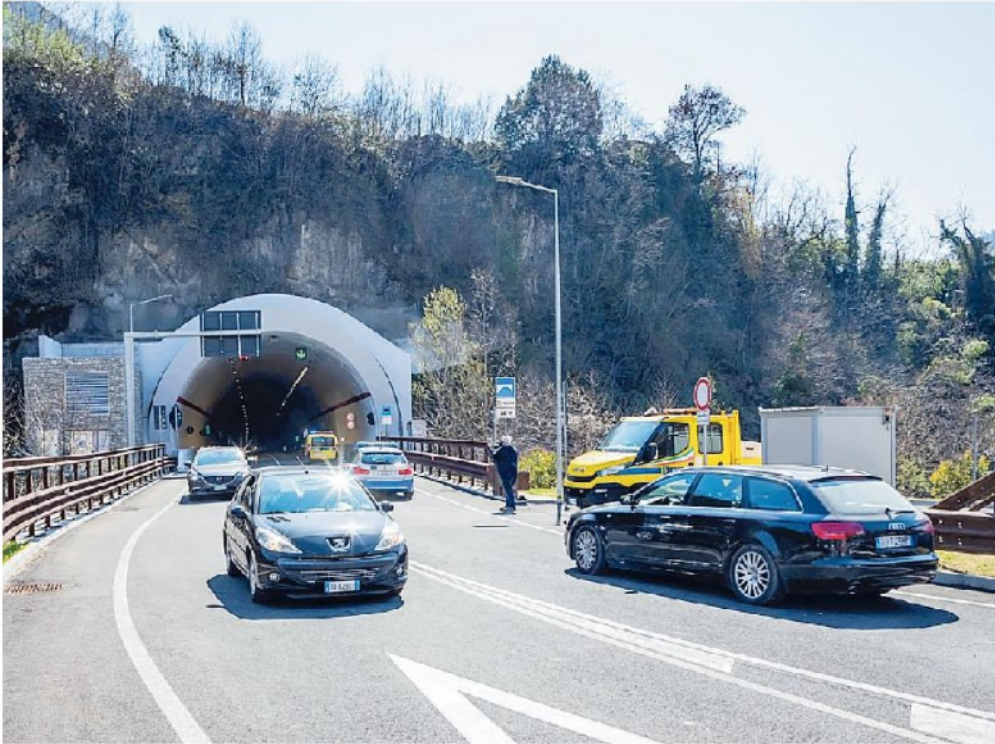
L'innesto nord del traforo di Santa Augusta, ieri mattina dopo l'apertura
