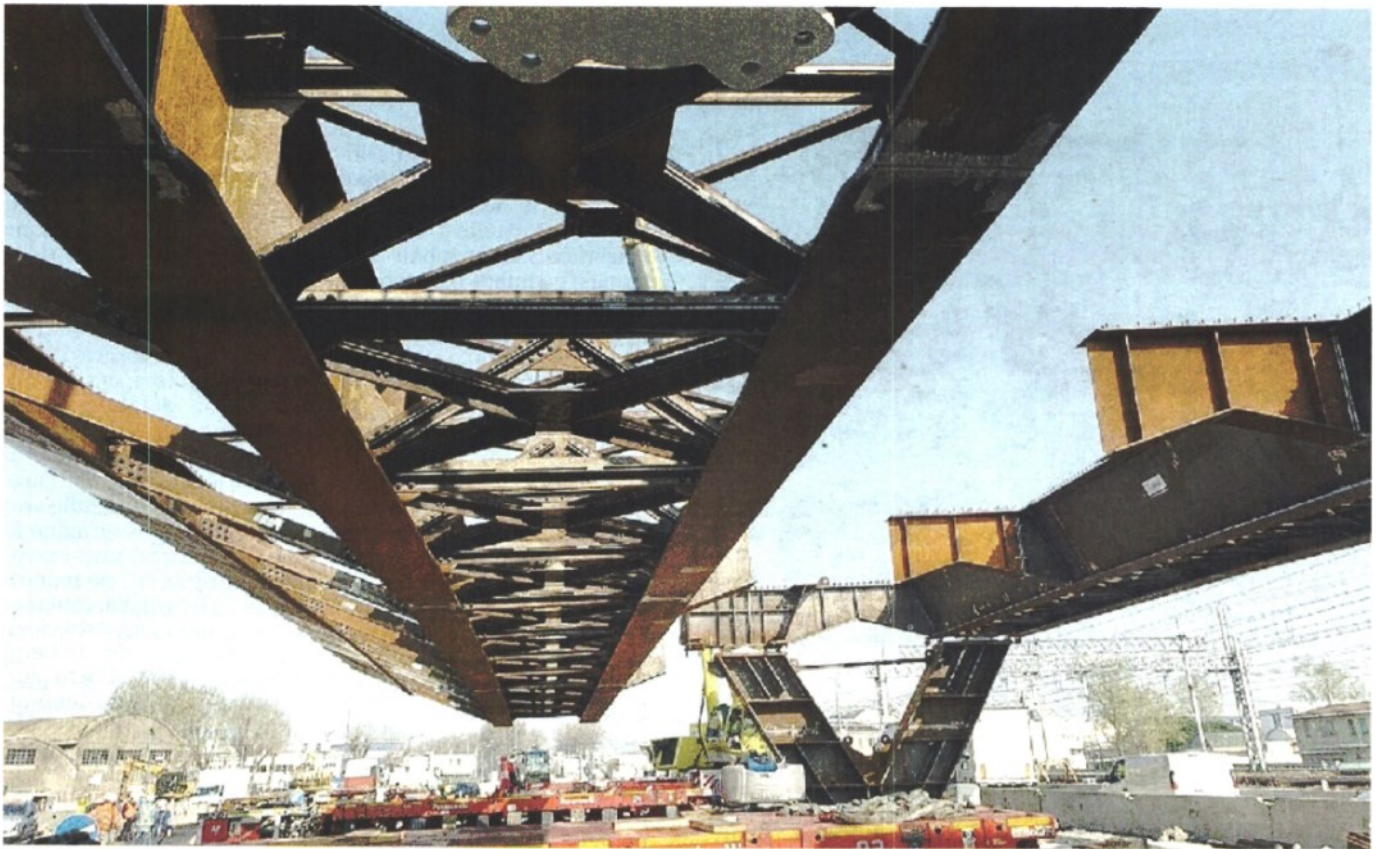
VIA DELLA LIBERTÀ La posa di uno dei conci del nuovo cavalcavia che rivoluzionerà la viabilità in via della Libertà e al Vega parco scientifico
