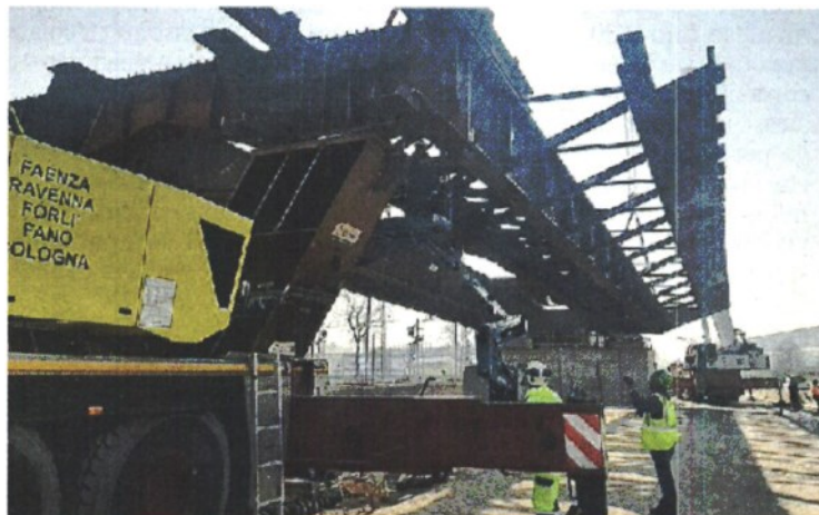
IL CANTIERE Le maestranze delle imprese all'opera
