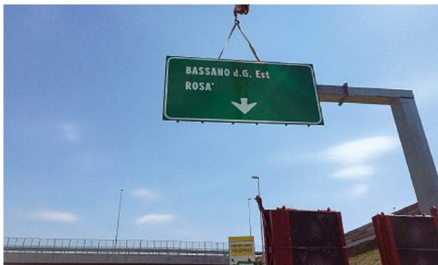
I cartelli Una gru posiziona i cartelli dei nuovi svincoli della superstrada Pedemontana che, da inizio maggio, sarà percorribile per altri 35 km da Bassano Ovest a Montebelluna
