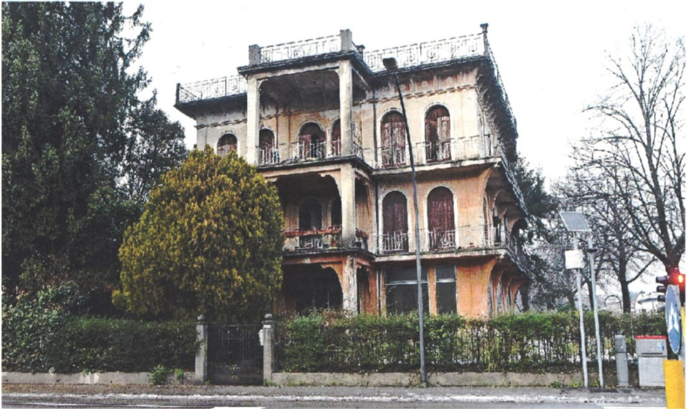
IL GIALLO La villa Liberty in viale IV Novembre che dovrebbe essere abbattuta per far spazio a un palazzo da 17 appartamenti
