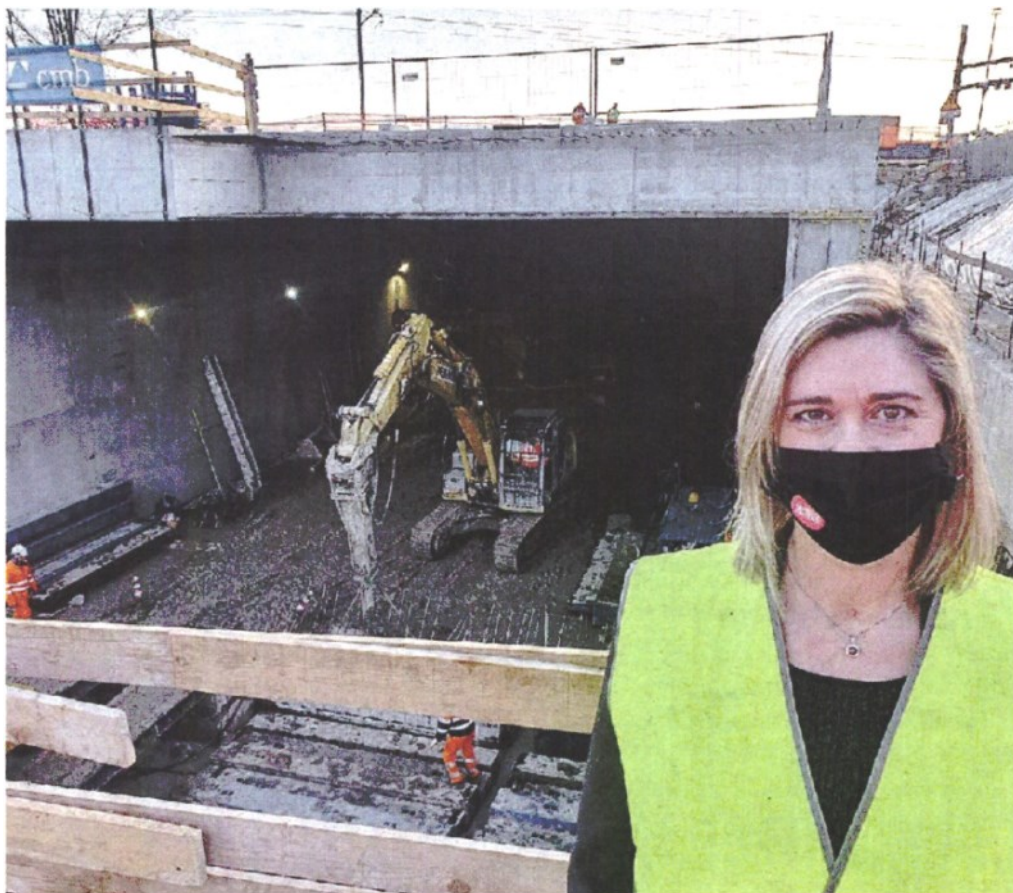
IL CANTIERE Ultimata l'installazione del sottopasso in via Udine, l'assessore Cristina Amirante
