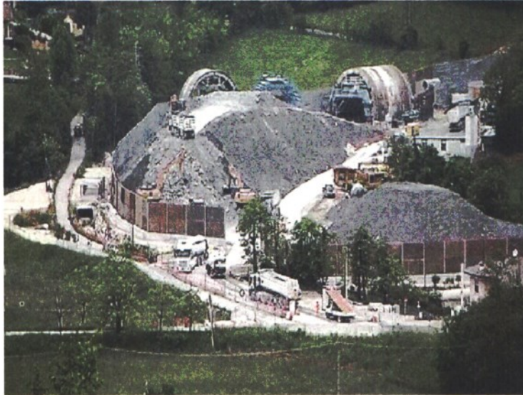
LAVORI IN CORSO DI ULTIMAZIONE Qui sopra il cantiere della galleria di Malo, in provincia di Vicenza. A sinistra lo svincolo di Montebelluna, nel Trevigiano
