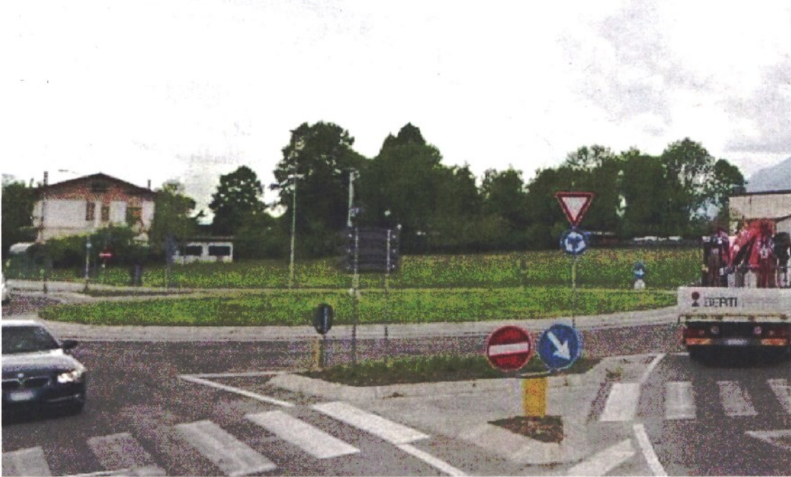
ALLA ROTATORIA delle Gravazze a Santa Giustina da domani iniziano i lavori per realizzare il sottopasso per la pista ciclabile. La Statale 50 sarà quindi di fatto tagliata a metà
