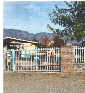
LA CONVENZIONE L'asilo di via San Fermo verrà messo a norma
