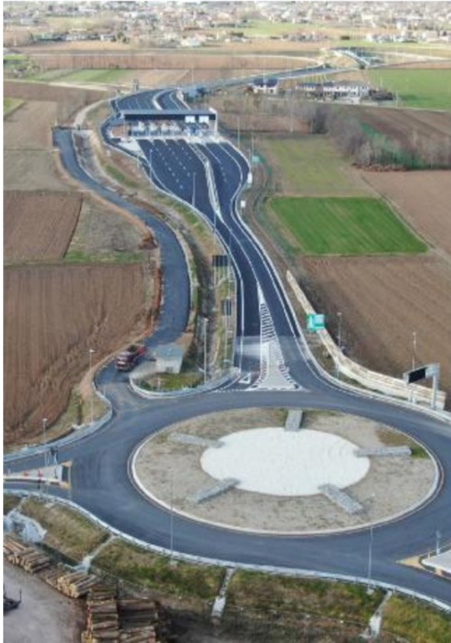
Superstrada Il casello Mussolente-Loria della Pedemontana FOTO CECCON
