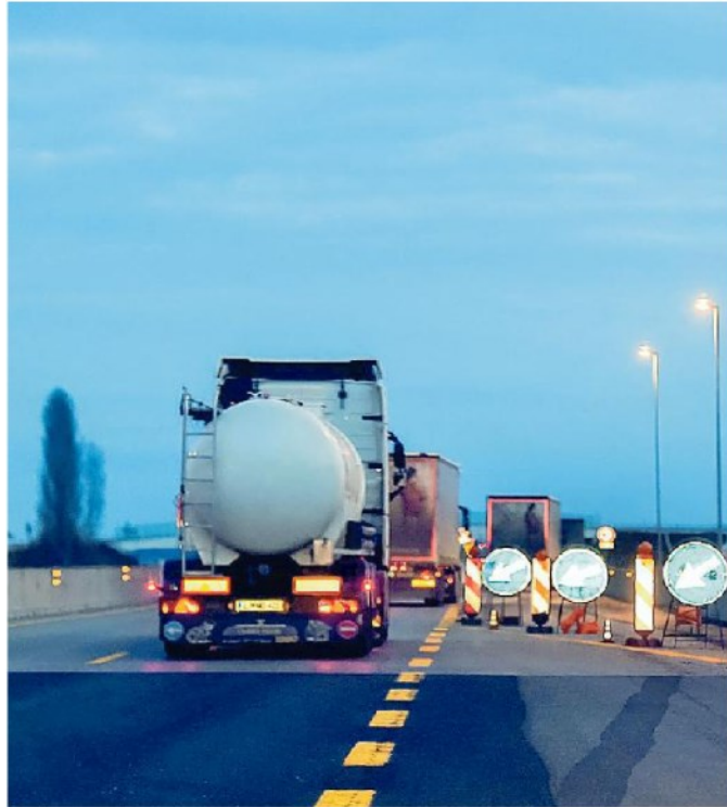
La A4 interessata dal cantiere della terza corsia FOTO SIMONE FERRARO
