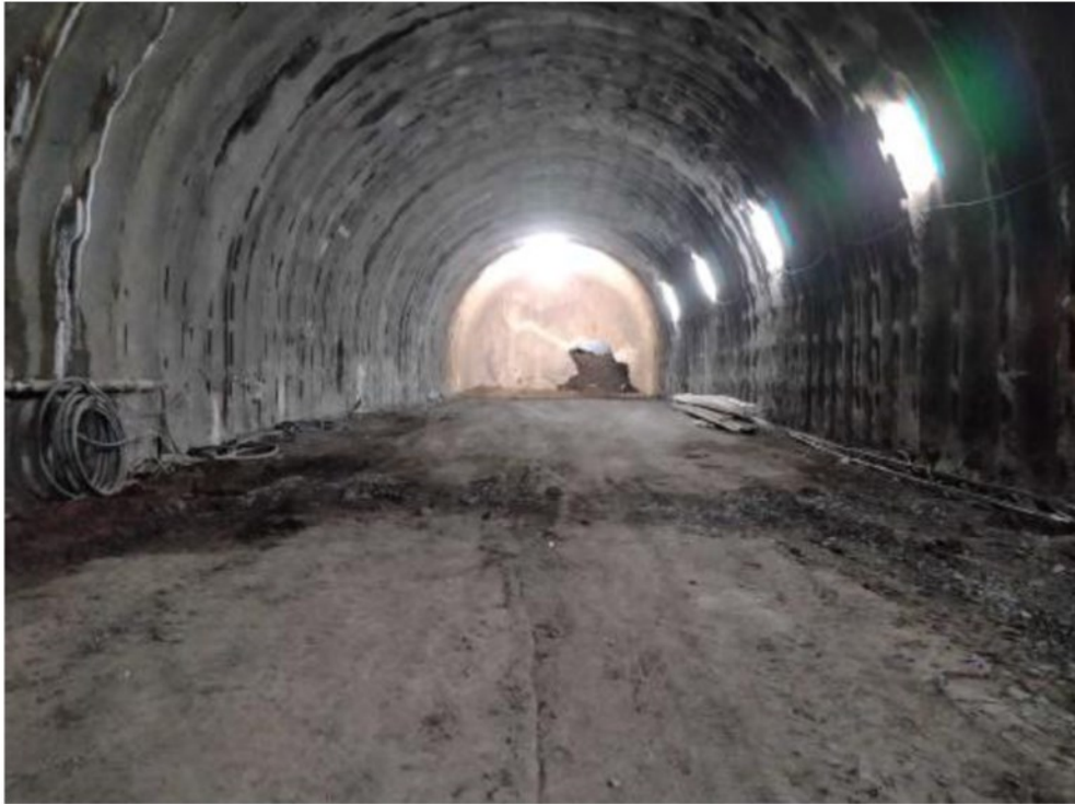
Abbattimento Il momento in cui la benna sfonda l'ultimo diaframma della galleria nord della Pedemontana a Malo
