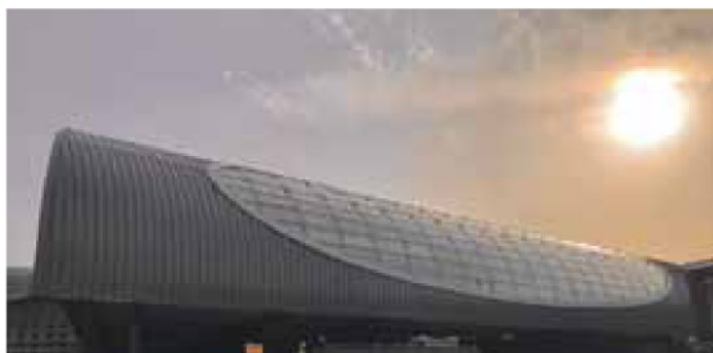
L'azienda friulana Simeon sta realizzando le facciate dei terminal T1 e T2 dell'aeroporto Charles De Gaulle, a Parigi
