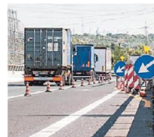
Lavori sulla A4
