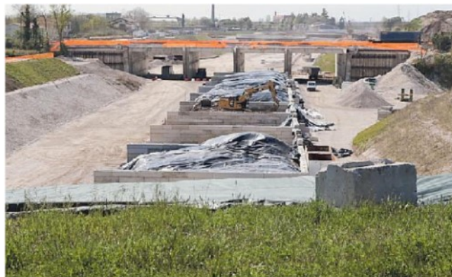
La discarica che blocca il cantiere della Pedemontana
