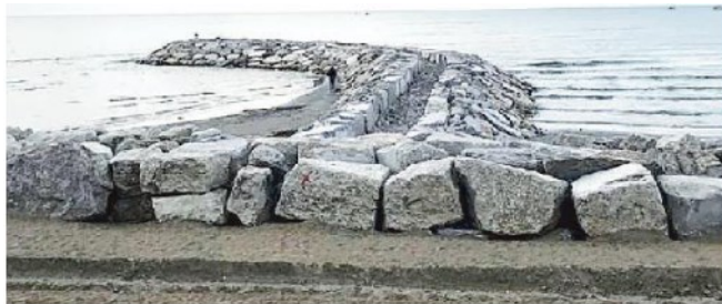
La nuova barriera frangiflutti realizzata a Caorle
