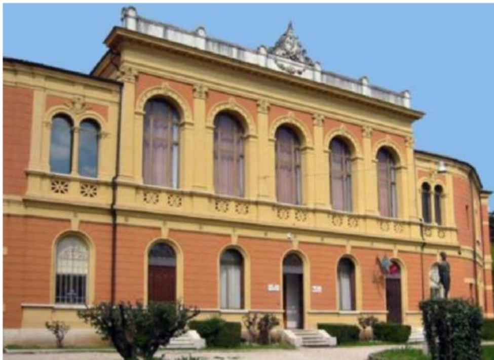
Miglioramento sismico In dirittura d'arrivo i lavori per rendere più sicura la scuola elementare Fogazzaro. ZORDAN
