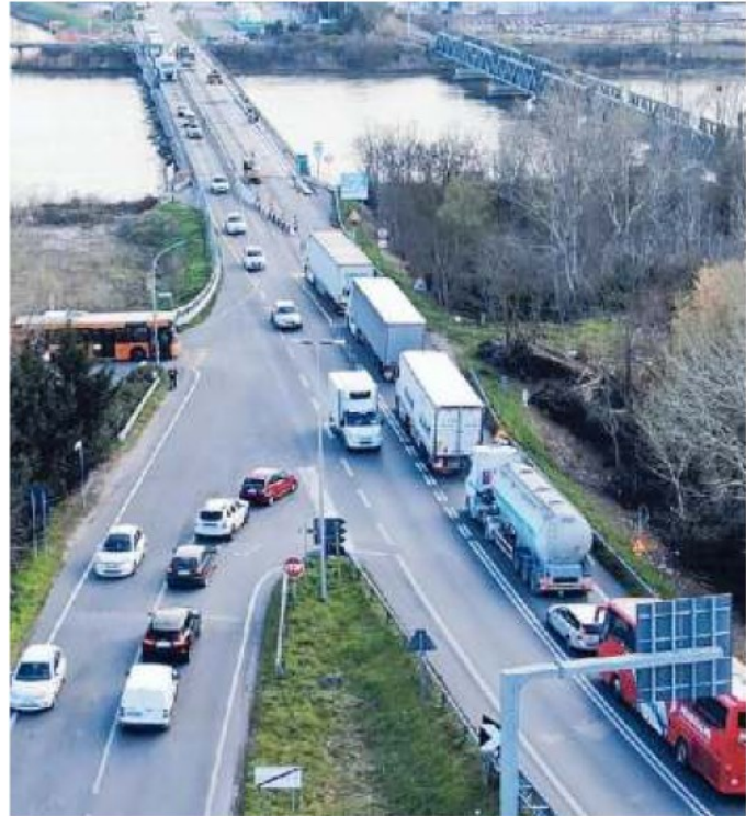
Le costanti code al cantiere sul ponte del Brenta gestito dall' Anas
