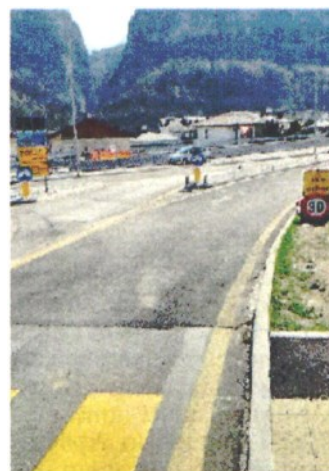
STATALE 51 Il nuovo tratto
