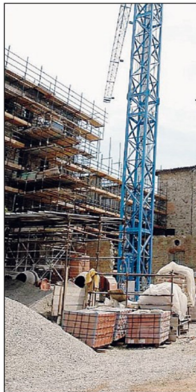
Un cantiere in edilizia
