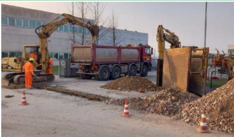
Cantieri e lavori edili agevolati grazie agli incentivi e soprattutto al superbonus
