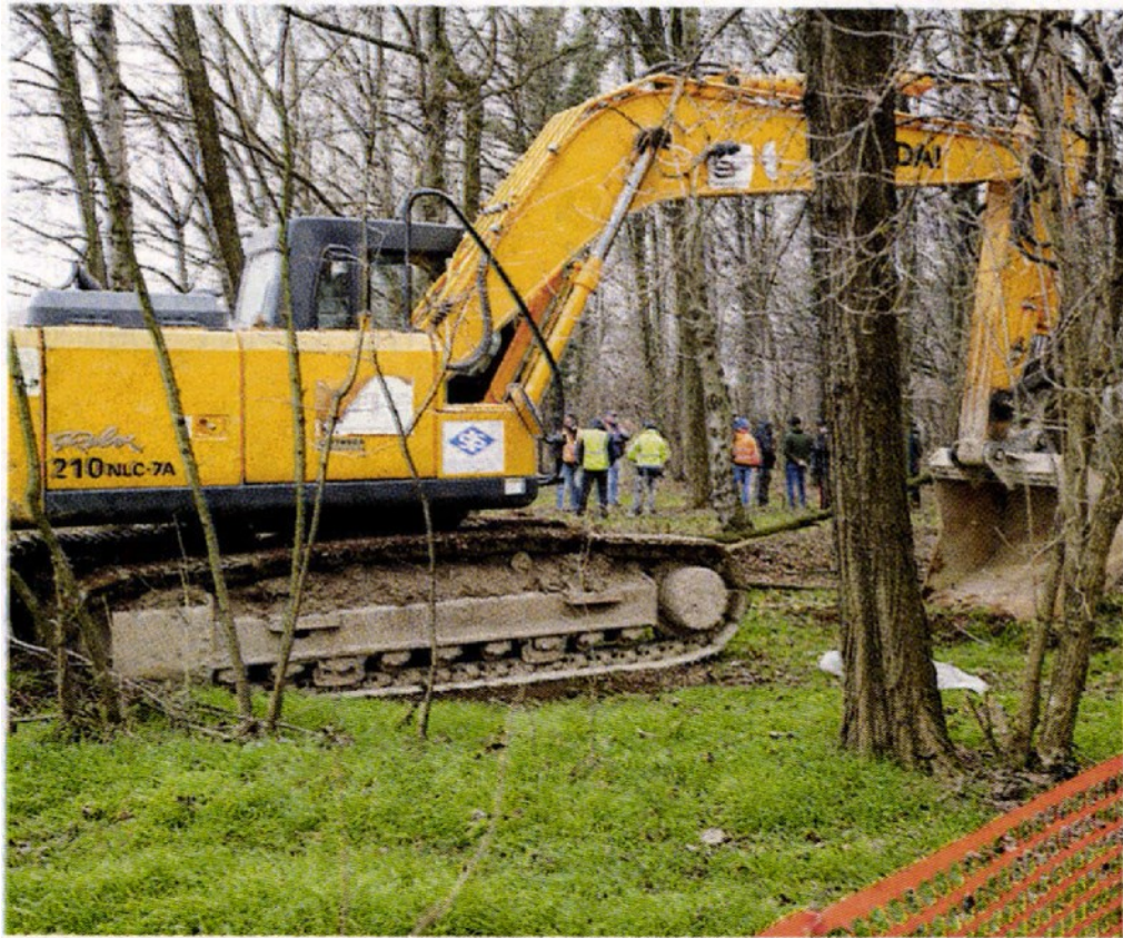
Le ruspe nel Bosco della Speranza, ad Altivole, per il cantiere della Spv
