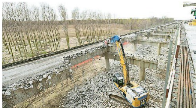
Una gru impegnata nei lavori di demolizione del ponte
