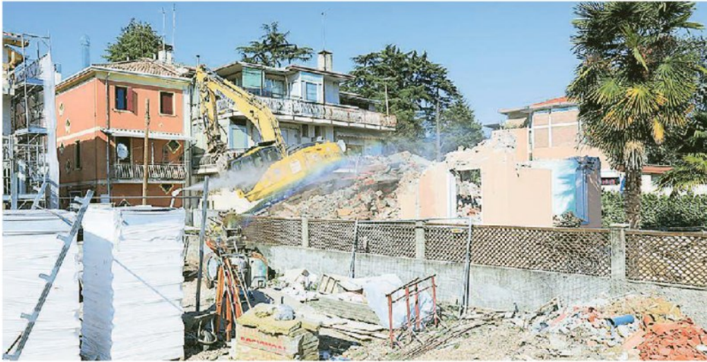
L'abbattimento di un'abitazione per realizzare il sottopasso in via Piave
