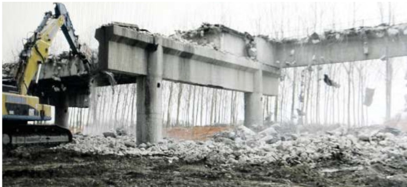
SAN MICHELE Partita la demolizione del vecchio ponte sul Tagliamento
