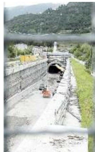
QUASI FATTA L'uscita del traforo su via Rindola Bassa
