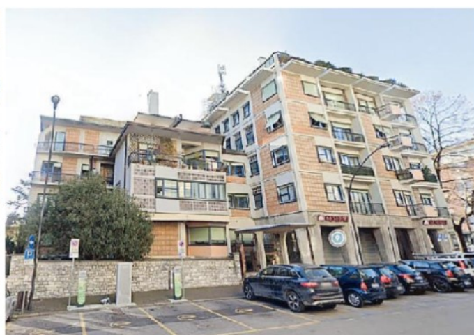
L'edificio Ina in Largo Porta Altinia è stato progettato dall'architetto Giuseppe Samonà e realizzato tra il 1949 e il 1953.
