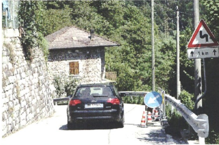
STRADA PIÙ SICURA con la galleria Pala Rossa che diventa realtà
