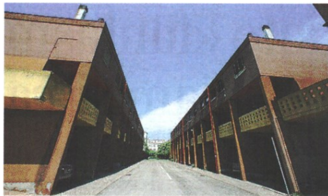
Conto alla rovescia I lavori di restauro interesseranno il quartiere Pertini
