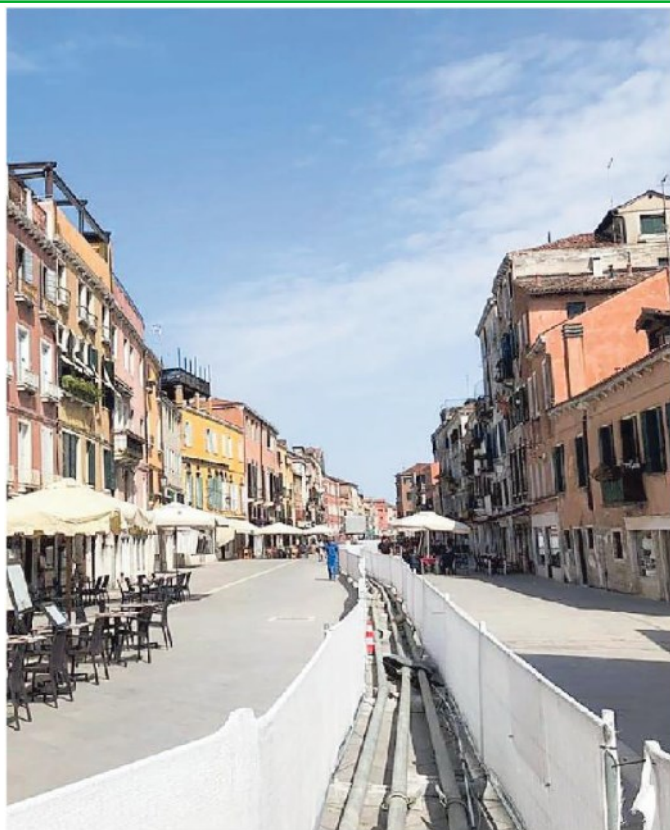
Uno degli interventi in corso in via Garibaldi
