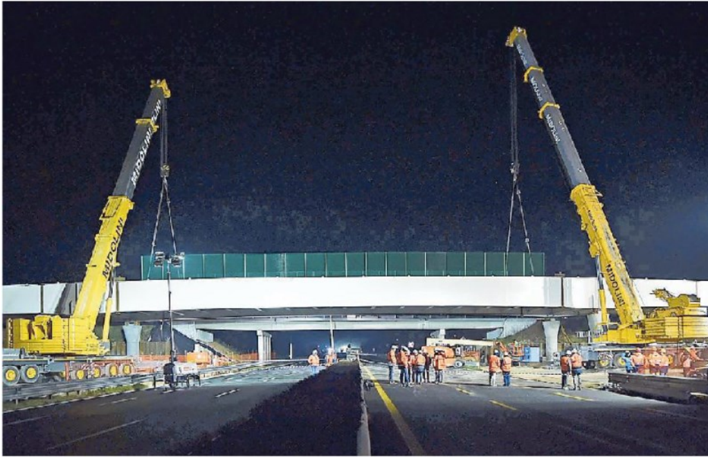
La posa in opera di un cavalcavia nel cantiere della Terza corsia sulla A4
