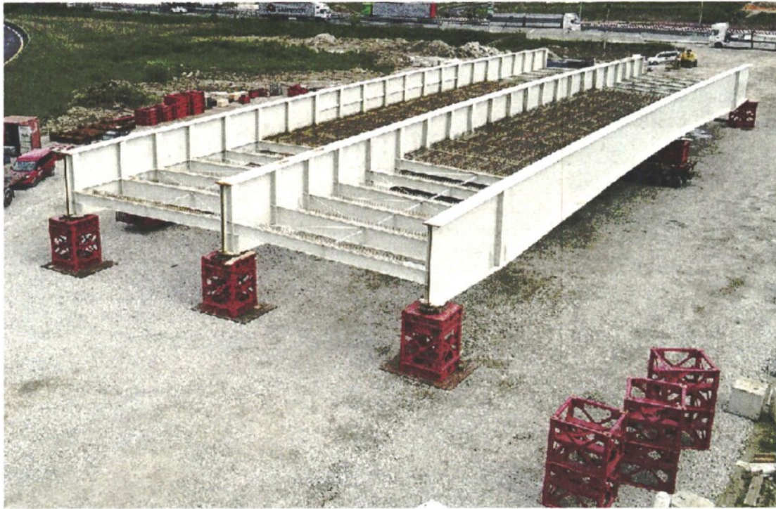
POSA NOTTURNA Il nuovo cavalcavia ha una campata centrale di 60 metri: in tutto è lungo 103 metri
