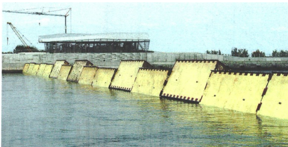
in azione Le paratoie durante uno dei sollevamenti di questi mesi: il Mose ha già difeso Venezia dall'acqua alta per venti volte
