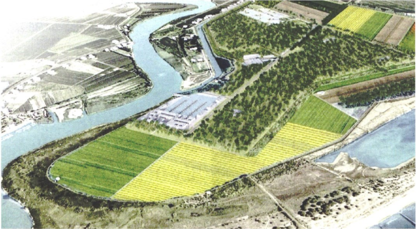
TRA MARE E FIUME L'area dove la Human Company investirà cento milioni di euro in una nuova struttura turistica
