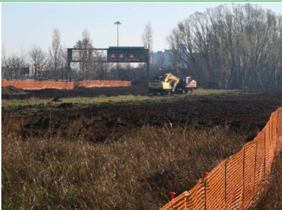
Cantieri I lavori per la Tav lungo l'autostrada a San Martino Buon Albergo in una foto del dicembre 2020
