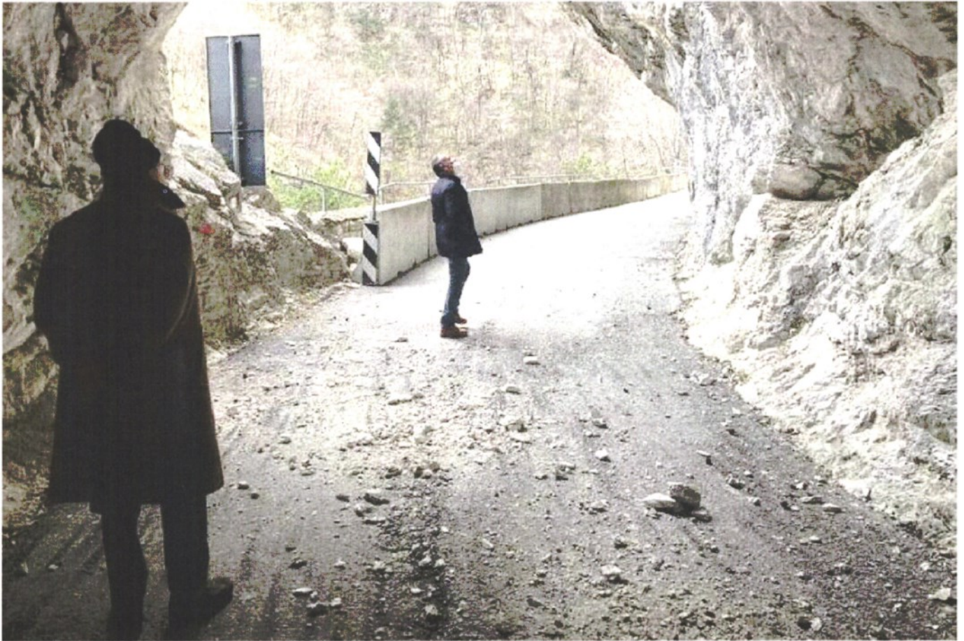
UN RECENTE sopralluogo sulla strada provinciale della valle del Mis: i lavori sono iniziati, ora serve un coordinamento con il Genio
