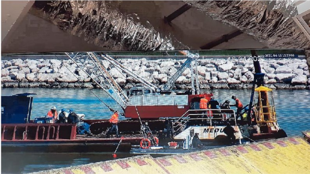
Ispezione della Finanza nelle paratoie della schiera di Punta Sabbioni
