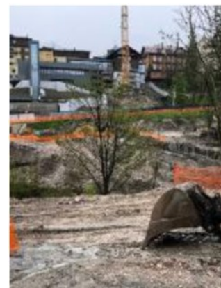
Cortina: cantiere del ponte sul Boite
