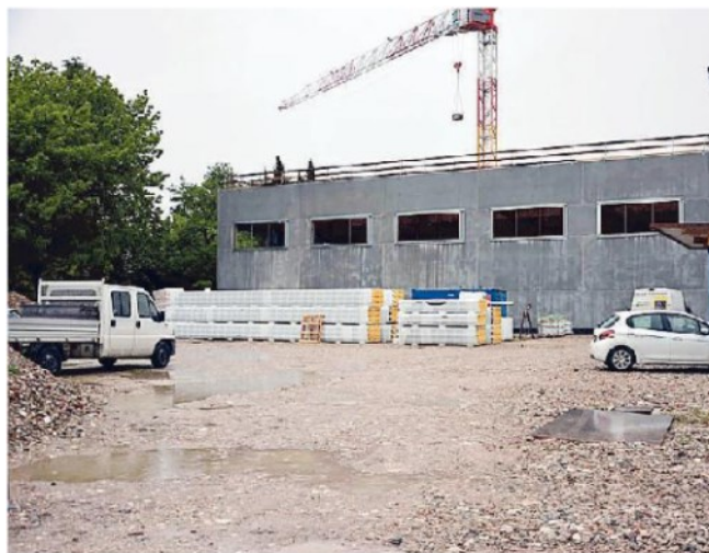
Il cantiere per la costruzione del nuovo plesso scolastico
