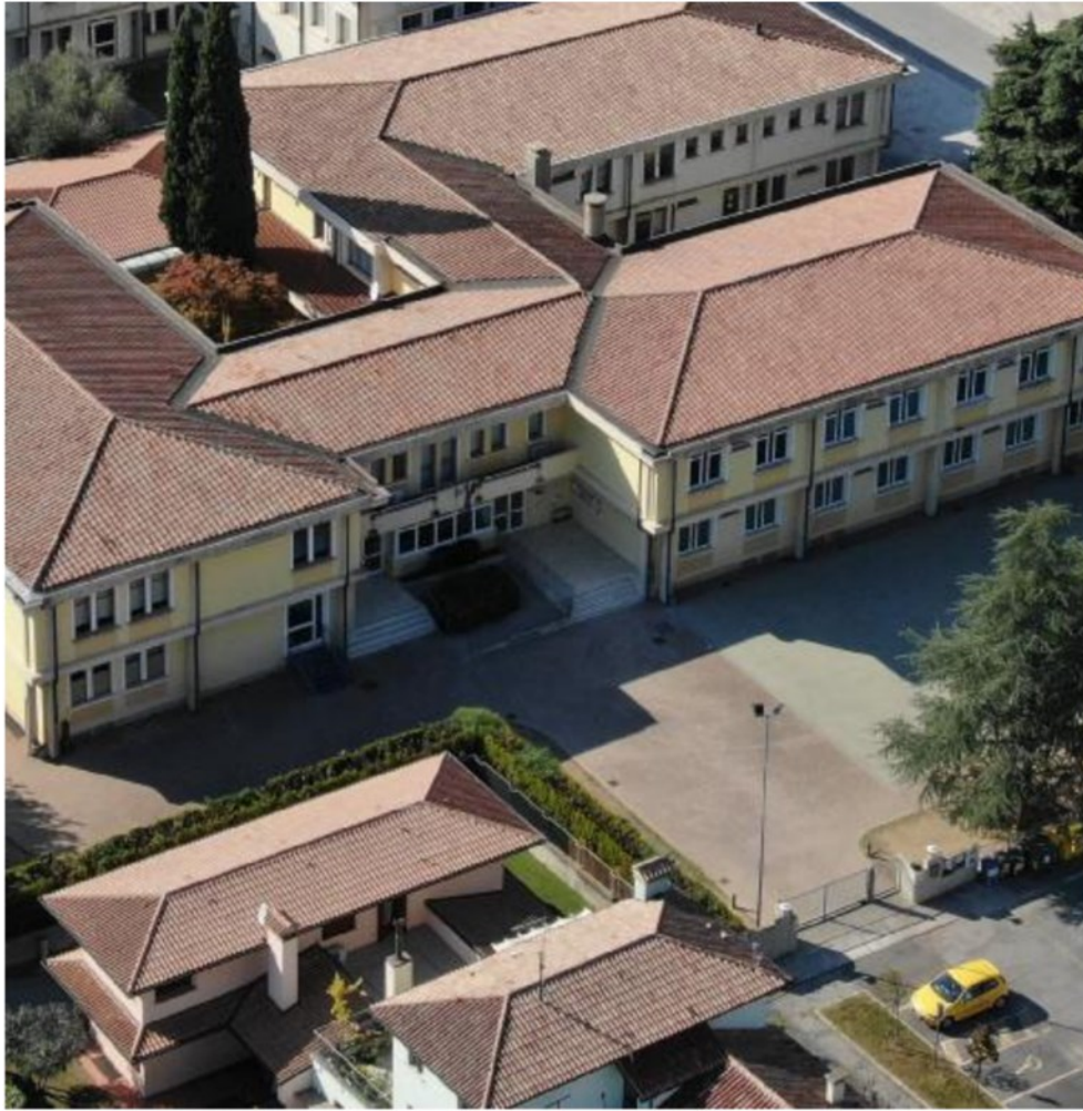
San Giuseppe La scuola primaria della frazione. In progetto la messa in sicurezza FOTO CEGCON
