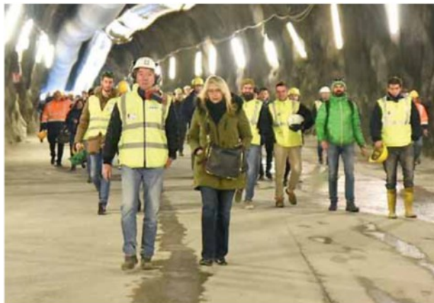
• Una visita al cantiere del tunnel di base del Brennero
