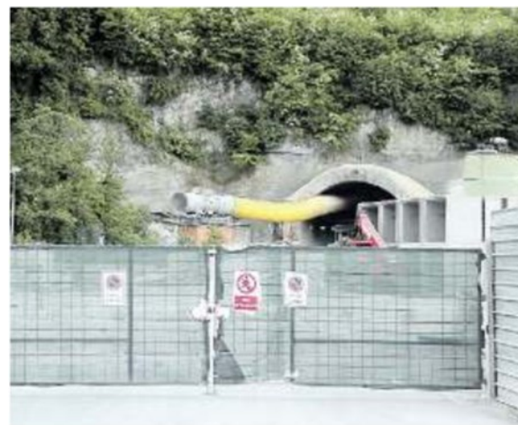
AL LAVORO Lo svincolo a Rindola del traforo di Santa Augusta
