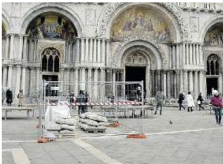
NIENTE PIÙ ACQUA La basilica di San Marco e i lavori all'esterno
