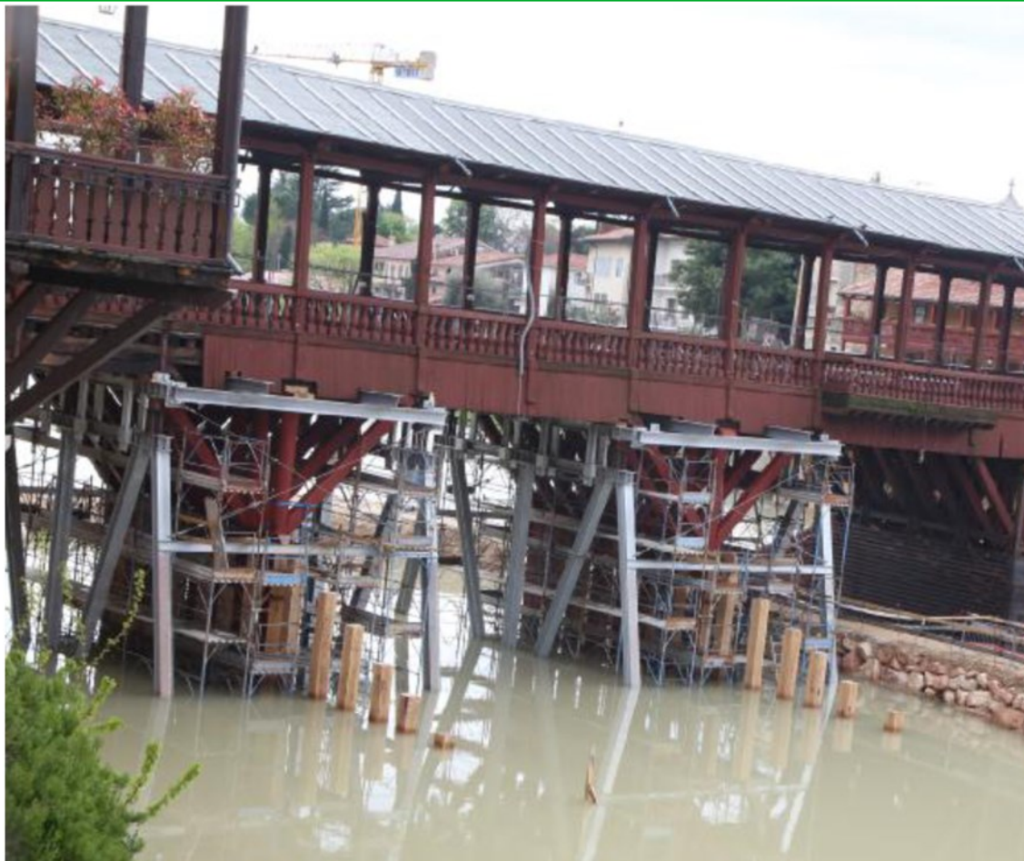
Il cantiere del Ponte degli Alpini allagato per la piena del Brenta. CECCON
