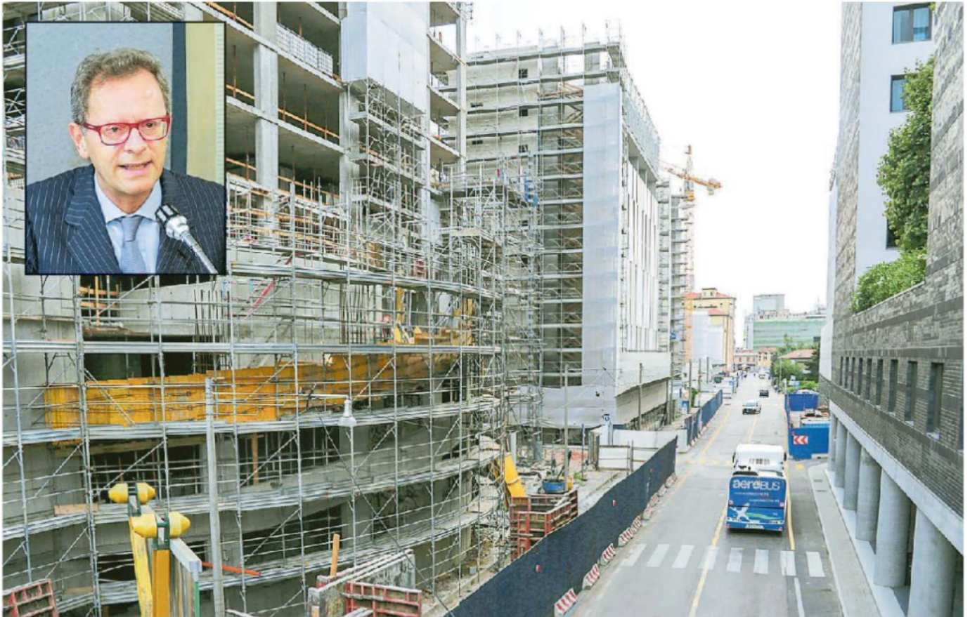
Alberghi in costruzione in via Ca' Marcello. nella foto piccola, Gian Angelo Bellati
