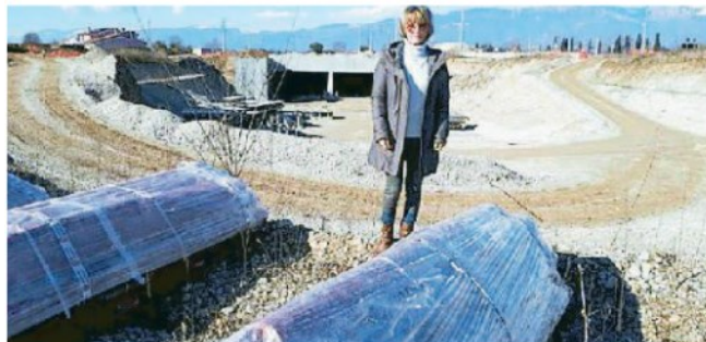
L'amianto trovato nel cantiere della Pedemontana ad Altivole
