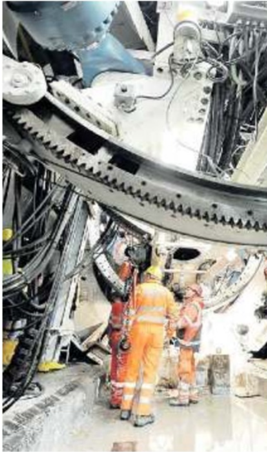
Il cantiere per la linea ferroviaria Torino-Lione a Chiomonte
