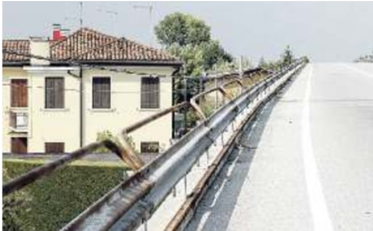
CONDIZIONI PRECARIE Il ponte di via I Maggio a Piazza Vecchia di Mira
