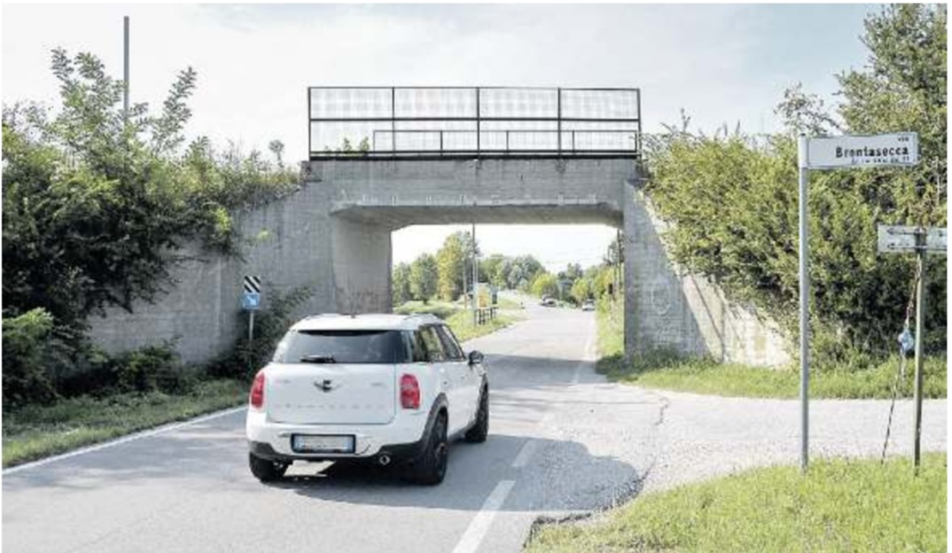
MESSA IN SICUREZZA Tra i 5 ponti interessati dai lavori quello di via Brentasecca a Dolo
