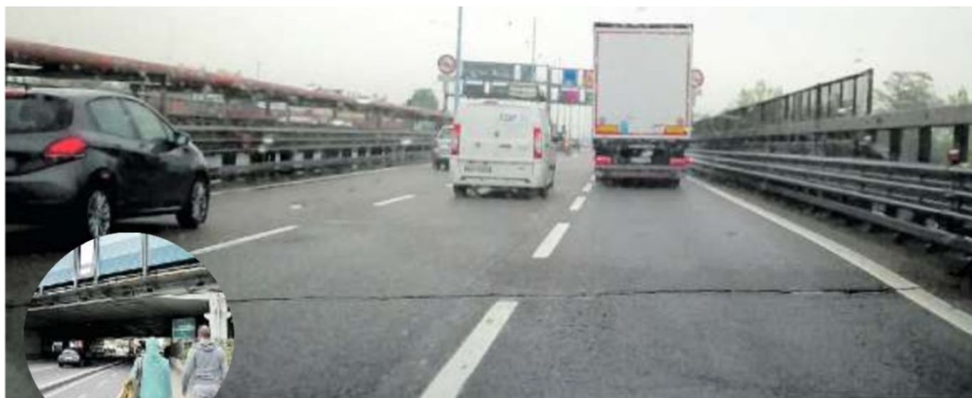
DA SOSTITUIRE Uno dei giunti evidentemente usurati tra le uscite di Marghera e di via Miranese, che verrà sostituito con una nuova tipologia in acciaio. Nel tondo, la Tangenziale in via Trieste
