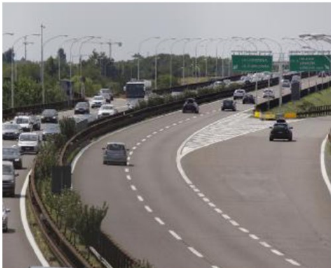
L'autostrada del Brennero all'altezza dell'intersezione con la A4
