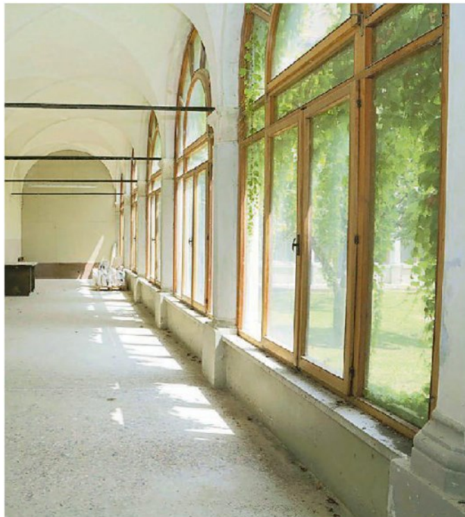
Bailo, il secondo chiostro sarà una delle aree del cantiere
