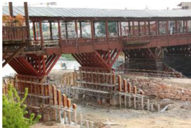
Il cantiere del Ponte Vecchio ieri da via Pusterla. CECCON
