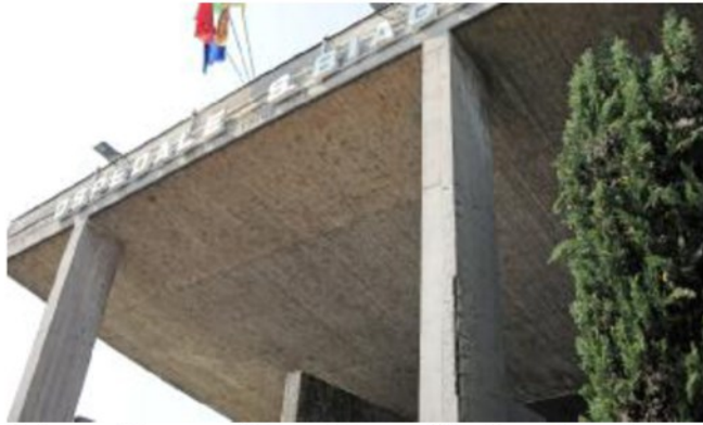
Il pilastro all'ingresso dell'ospedale con evidenti segni di erosione
