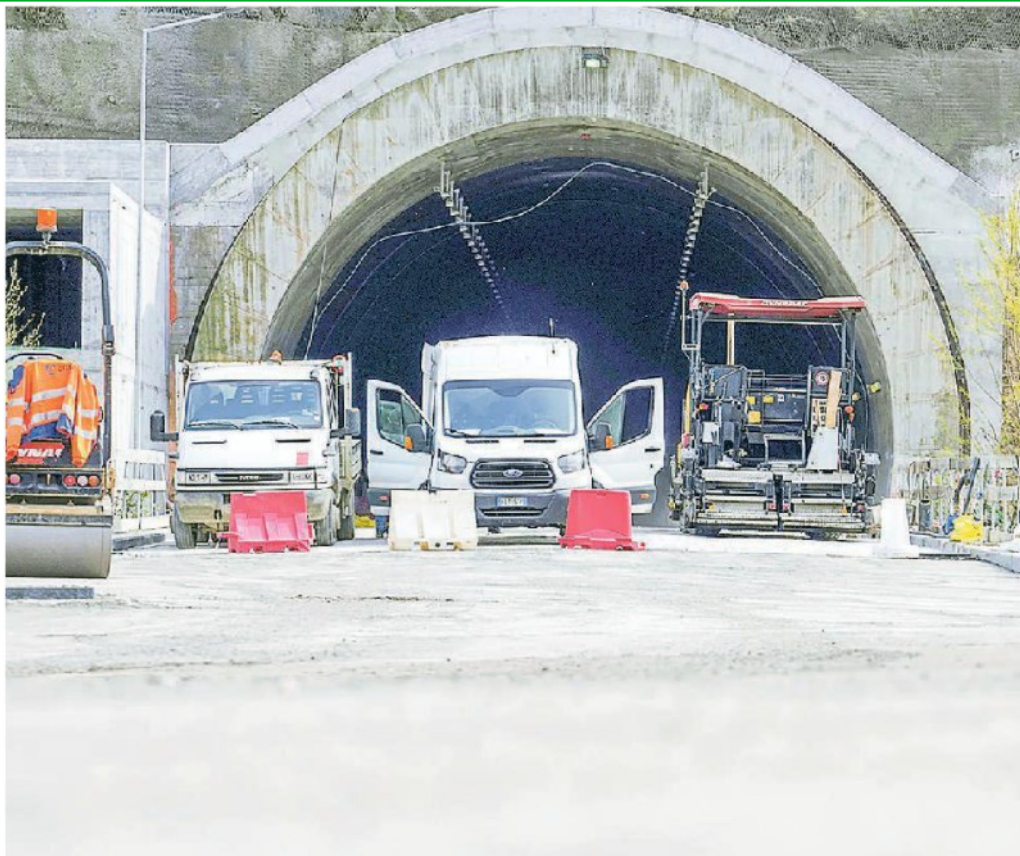
Il traforo di Sant'Augusta nell'ingresso a Nord di Vittorio Veneto
