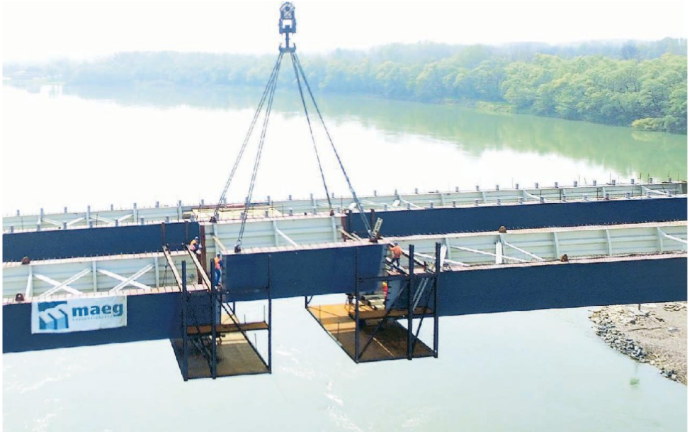
La posa dell'ultimo "concio" per completare il ponte realizzato dalla Maeg tra Bosnia e Croazia
