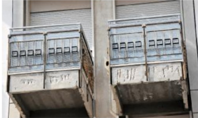
Cemento armato danneggiato nei terrazzi del «San Biagio» DIENNE
