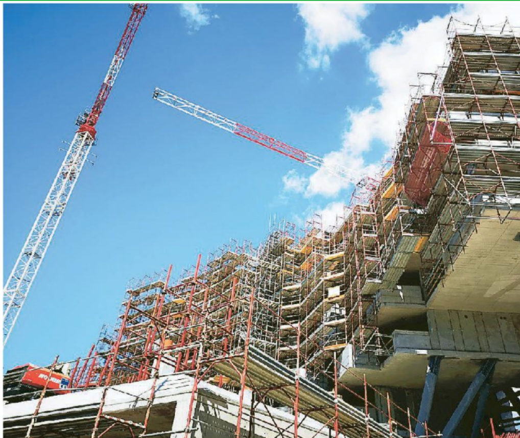
Il grande cantiere al centro delle discussioni per l'impatto che sta provocando sulla zona turistica
