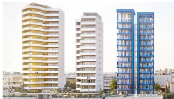
In cantiere. La Cross Lam Tower di Jesolo (a destra) firmata da Demogo e promossa da Urban-Bio, 14 piani in legno
