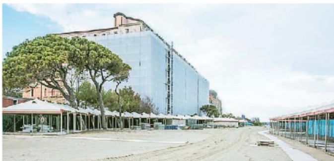
L'hotel Excelsior avvolto dai ponteggi
