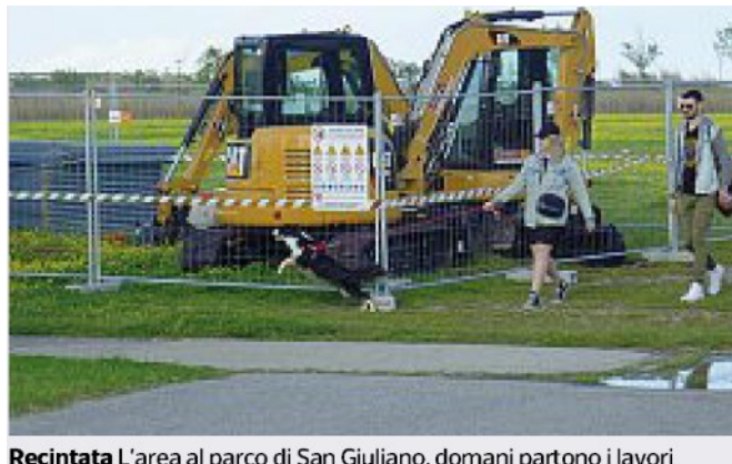
Recintata L'area al parco di San Giuliano, domani partono i lavori
