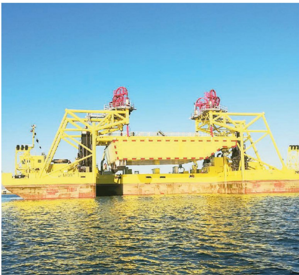
Mose, il jack-up al lavoro per sistemare le ultime paratoie sul fondale del Lido-San Nicolò
