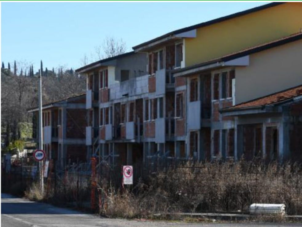
Il cantiere edile fermo in località Zappo a Lazise
