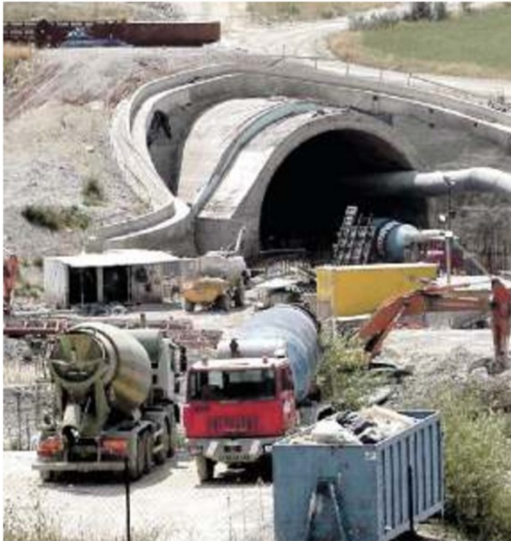
Uno dei pochi cantieri attivi in Italia
